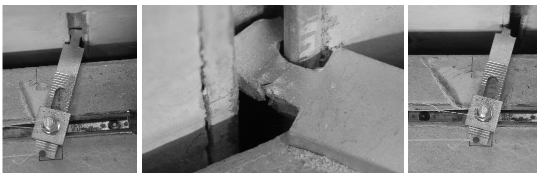
Slika 3.10: Stiki TA-AS s kanali HTA 40/22: zagozdenje glave jeklene ploščice v kanalu v panelu (levo), velike plastične deformacije pod glavo ploščice (v sredini) ter porušitev ploščice zaradi kombinacije upogibnih in nateznih obremenitev (desno).
