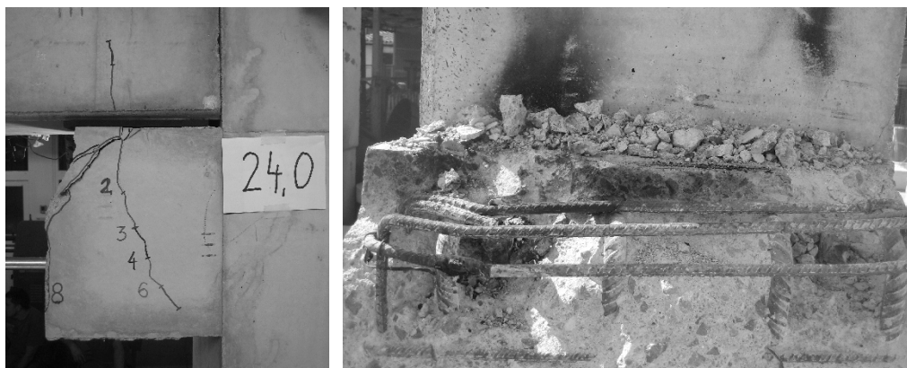
Slika 2.15: Preizkušanca S7: poškodbe v kratki konzoli ter gredi (levo) in porušena moznika (desno).
