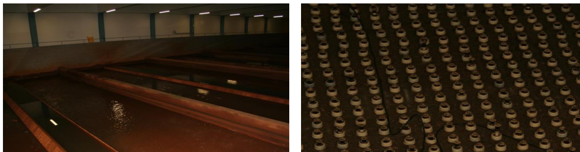
Slika 15: Fotografija počasnega peščenega filtra s šobnim dnom za čiščenje filtra Figure 15: Picture of slow sand filter with nozzle bottom for filter cleaning
