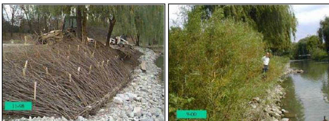
Slika 16: Zaščita brežine z vrbovim protjem takoj po izvedbi in dve leti kasneje (FISRWG, 2007)
