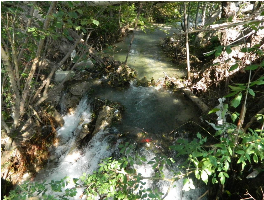
Slika 25: Motnja v toku na lokaciji prve lesene stopnje
