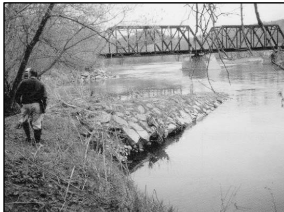
Slika 20: Zaščita mostnih opornikov z jezbicami (FISRWG, 2007)
