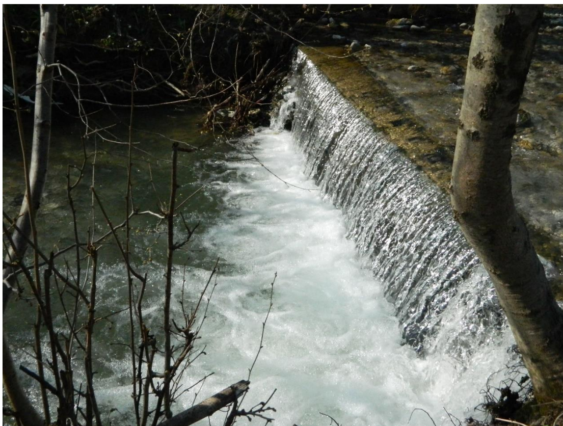
Slika 27: Gorvodni prag zgrajen iz betonskega opornika za kozolec
