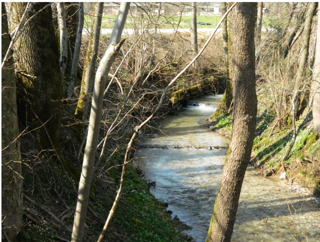
Slika 26: Dolvodni leseni stopnji v dobrem stanju
