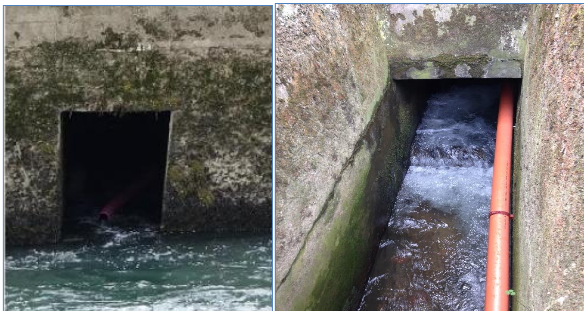
Slika 10: Natega za močnejši iztok vode iz ribje steze (Brilly in sod., 2015).
