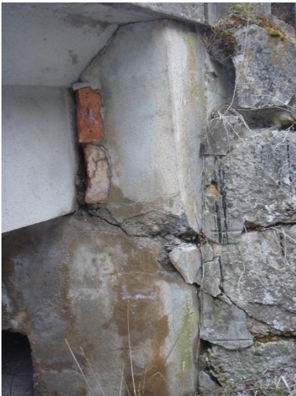
Slika 13: Razpokan krajni steber z vidnimi vpečnimi dodatki (vir: lasten)
