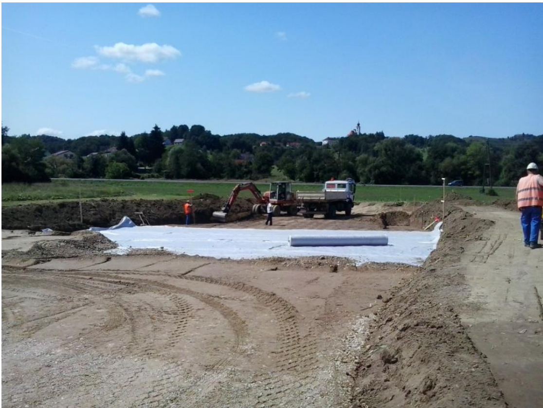
Slika 9: Polaganje ločilne geotekstilije [19]
