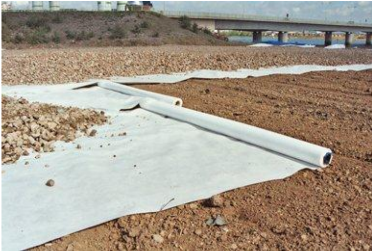
Slika 4: Polaganje ločilne geotekstilije pri gradnji prometnic [15]
