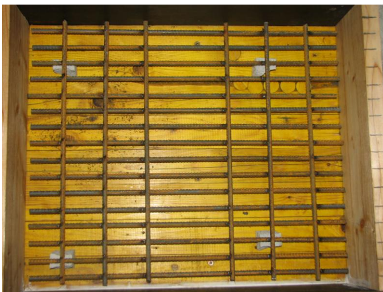
Slika 36: Opaž za betonsko ploščo z armaturo premera 8mm
