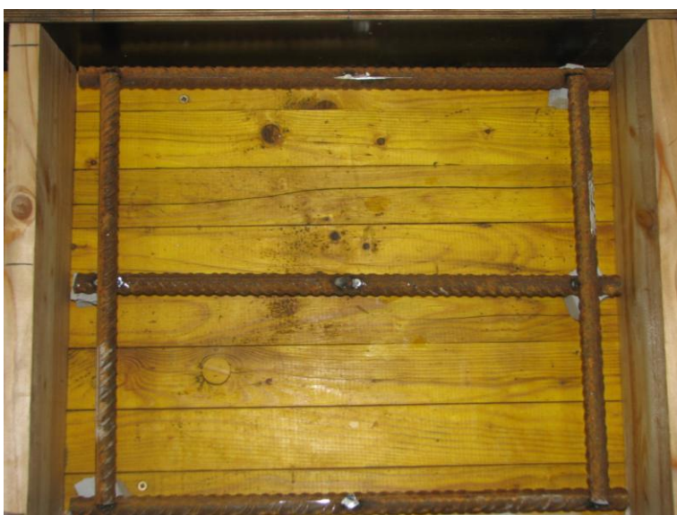
Slika 37: Opaž za betonsko ploščo z armaturo premera 20 mm
