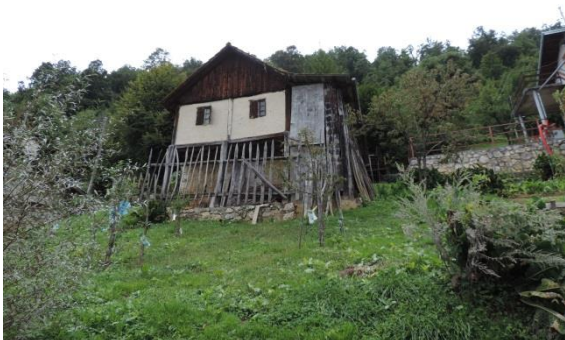
Slika 22: Zidanica postavljena pravokotno na padnice
