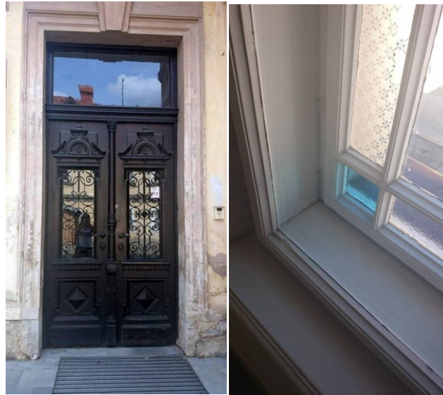
Slika 8: Vhod v objekt (levo) in škatlasto okno z enojno zasteklitvijo (desno) (lasten vir, 2015)
