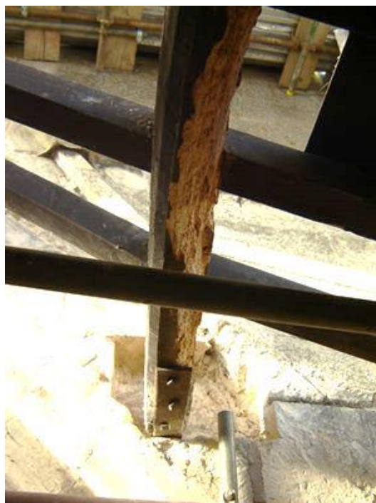
Slika 1.3: Nosilec z izrazito načeto lesno maso po napadu lesnih škodljivcev (Hoath, 2006)
