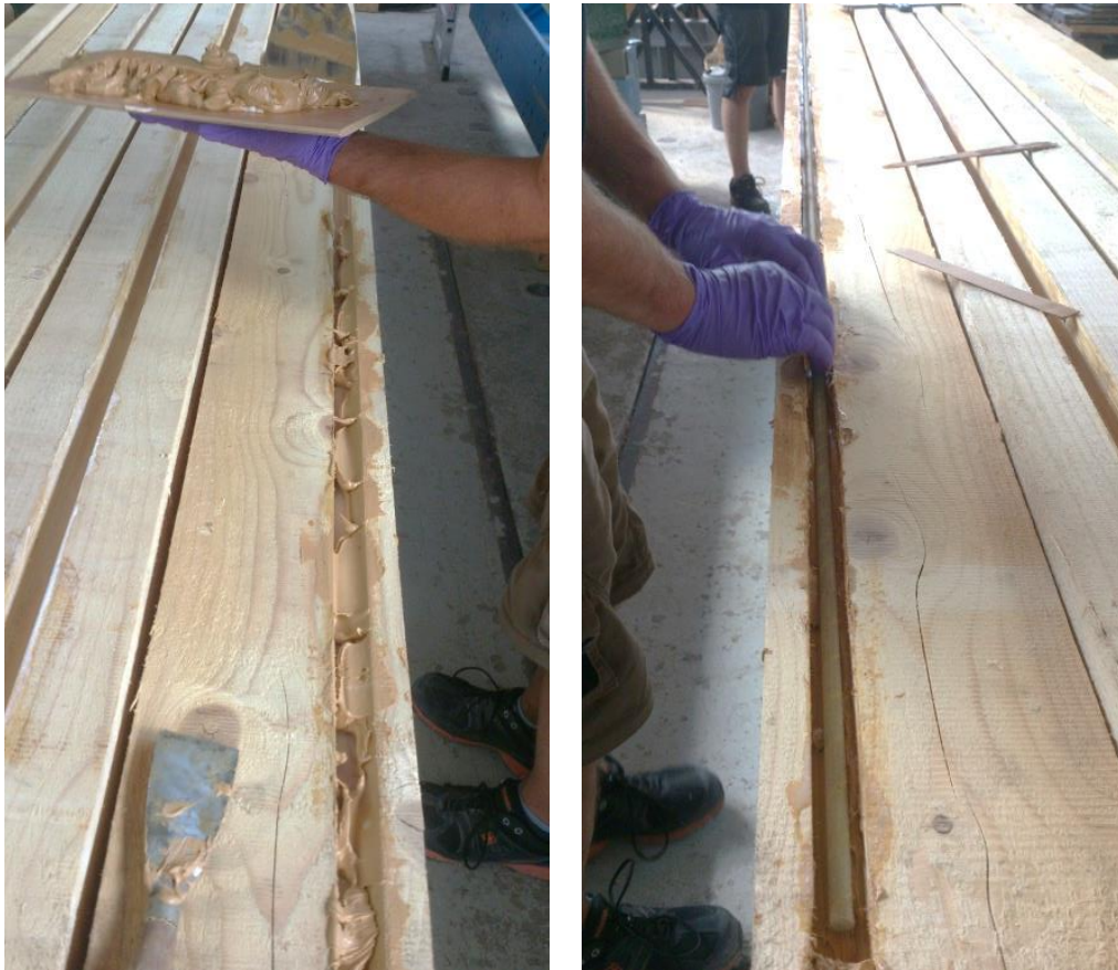
Slika 4.7: Priprava utorov: vgradnja epoksidne paste (levo), nameščanje palice (desno)
