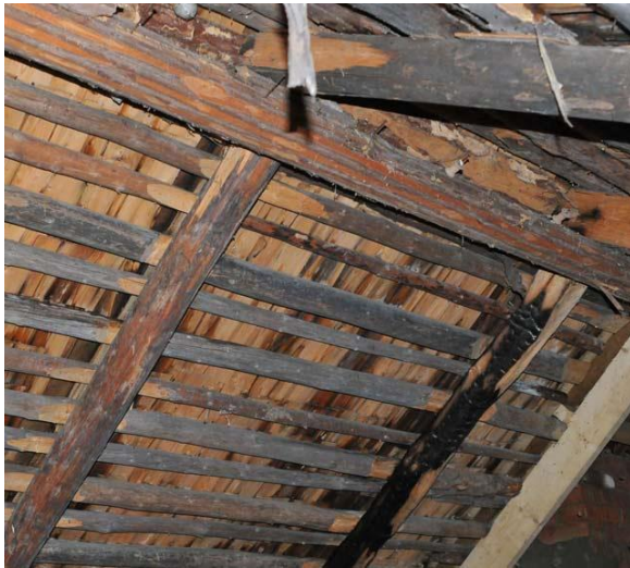
Slika 1.2: Nosilci, poškodovani v požaru (levo, http://bjornmoren.com/Moving-into-Kullfallet.html ), detajl poškodovanega nosilca s slabim prezračevanjem ob naleganju na zid (desno, Harte, 2013)
