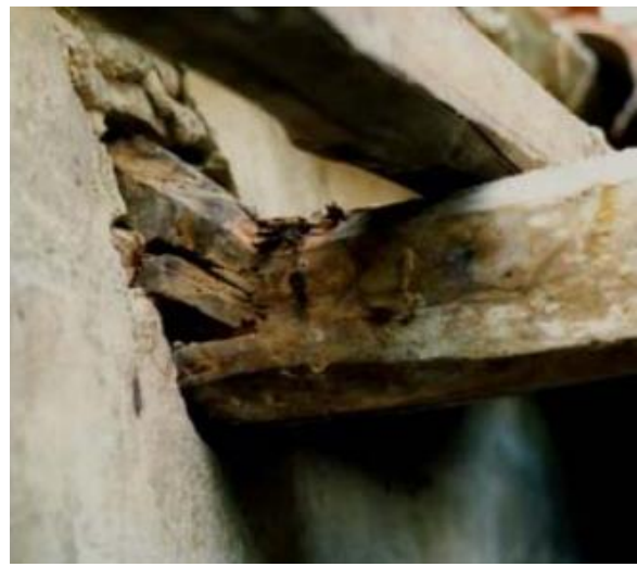
Slika 1.2: Nosilci, poškodovani v požaru (levo, http://bjornmoren.com/Moving-into-Kullfallet.html ), detajl poškodovanega nosilca s slabim prezračevanjem ob naleganju na zid (desno, Harte, 2013)
