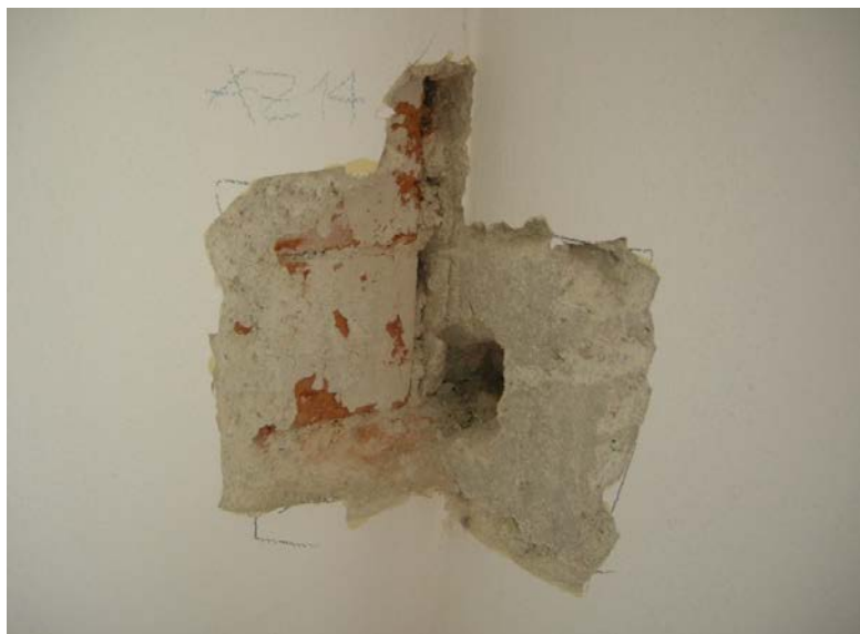
Slika 6: Stik notranje opečne stene debeline t = 20 cm in obodnega betonskega zidu (ZRMK, 2010)
