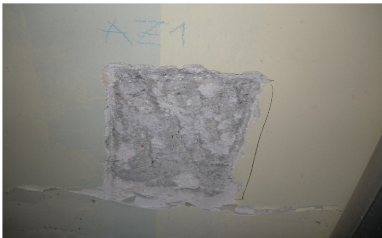
Slika 4: Izvedena sonda, kjer je pod ometom viden čvrst beton C 16/20 (ZRMK, 2010)
