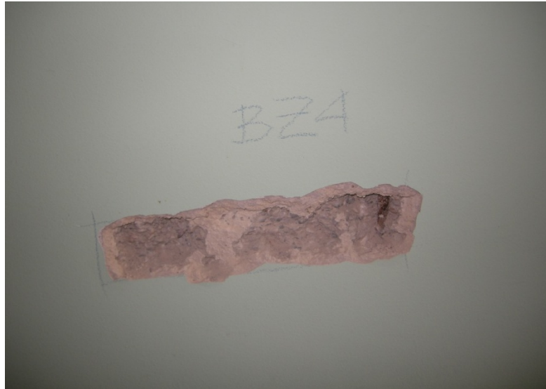
Slika 8: AB steber okvirja, kjer je bila ugotovljena tlačna trdnost betona 10–16 MPa (ZRMK, 2010)
