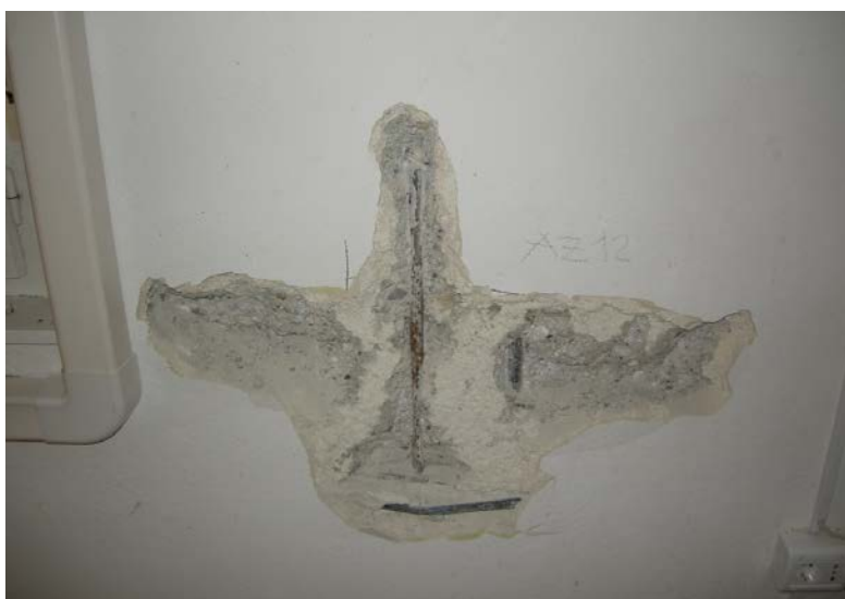
Slika 5: AB steber iz betona C 16/20 (ZRMK, 2010)
