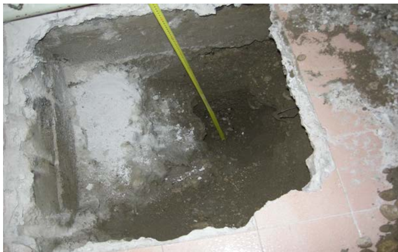
Slika 3: Pregled temeljev v kletni etaži (ZRMK, 2010)
