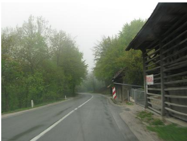
Slika 10: Nevarno mesto v km 5+900
