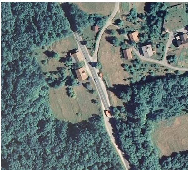
Slika 16: Ortofoto posnetek priključka za Vrhnico nad Želimljami v km 8+900
