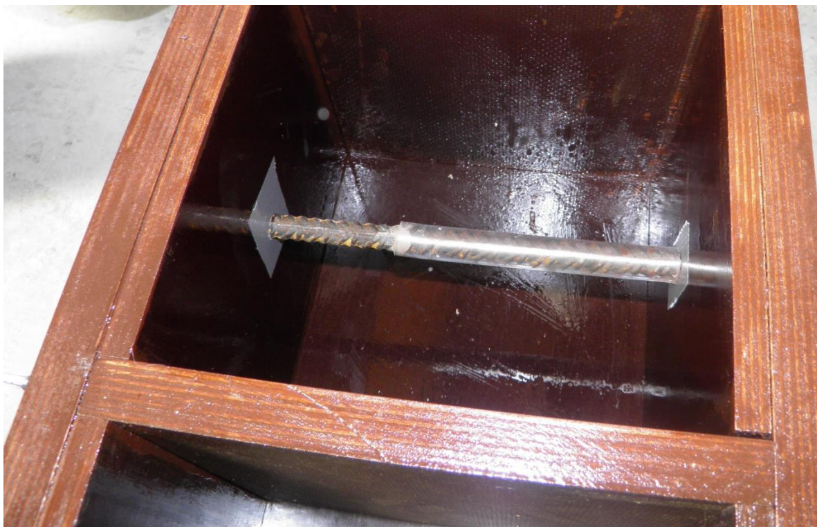
Slika 27: Zatesnitev stika med plastično cevjo in armaturno palico.
