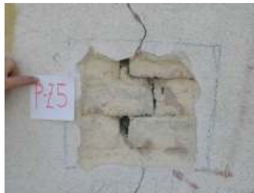
Slika 5: Zidana sonda P-Z5 (Bartol-Pohl in sod., 2006)
