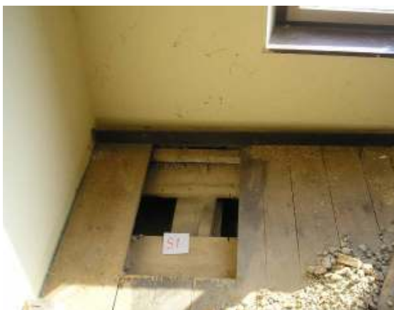
Slika 7: Strop nad kletjo na vzhodnem delu objekta (Bartol-Pohl in sod., 2006)
