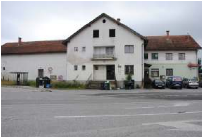
Slika 1: Severna fasada objekta (lasten vir)
