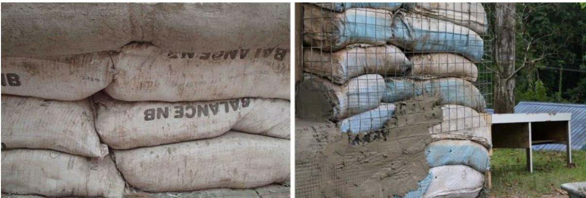
Slika 6: Prikaz zidu iz vreč brez in z armirno mrežo, na katero se nanese omet. (Vir slike 6: [26])
