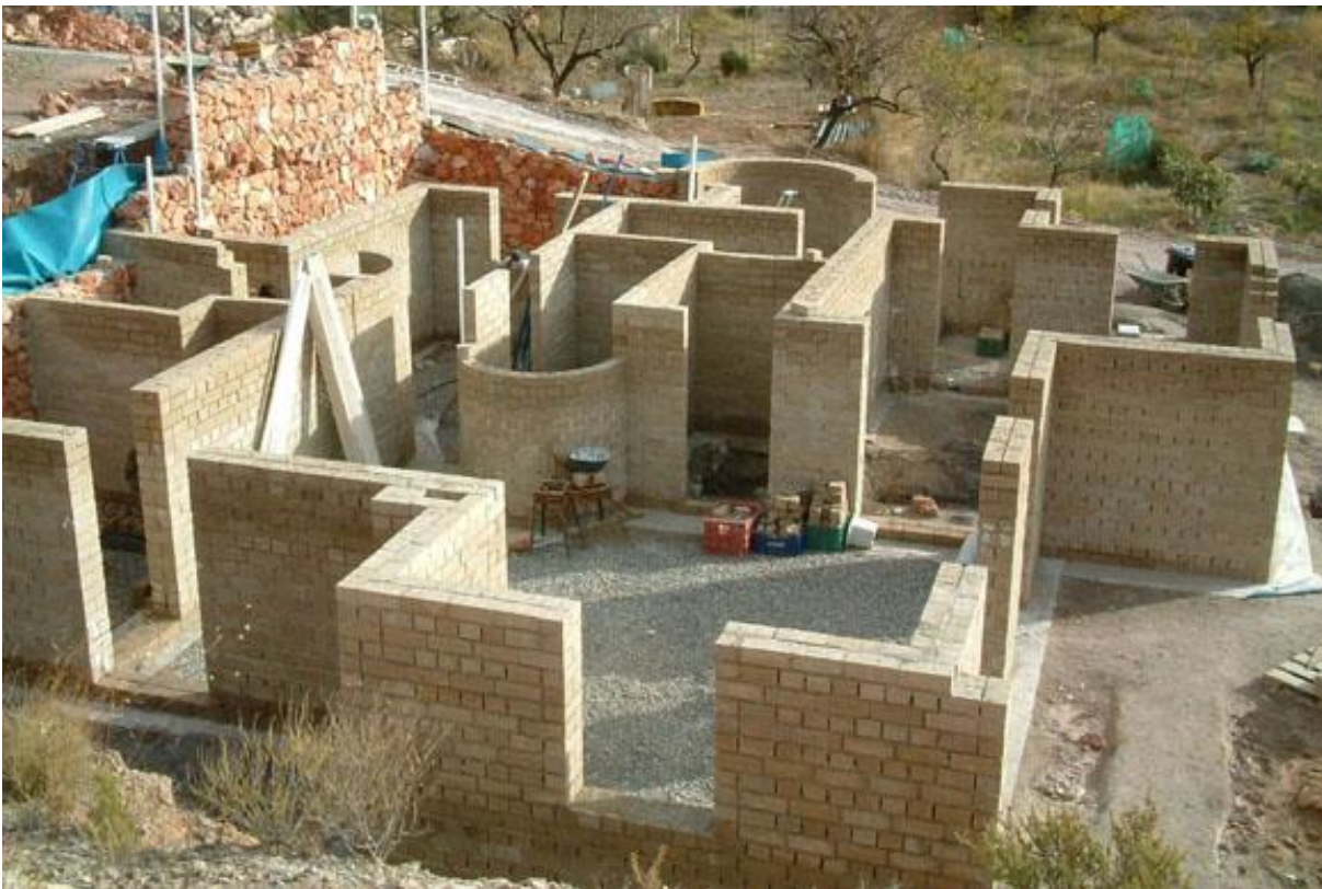
Slika 12: Zidovi hiše, grajeni iz konopljinega zidaka, ki imajo nosilno in izolacijsko funkcijo. (Vir slike 12: [50])
