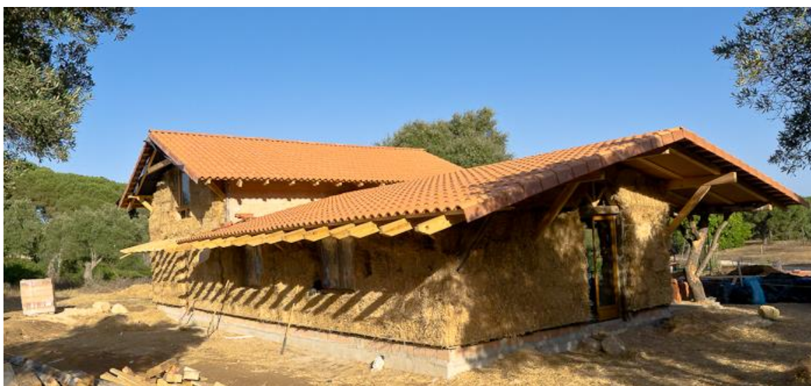
Slika 2: Neometana hiša, izvedena z endoskeltno konstrukcijo, ki kot polnilo uporablja slamnate bale. (Vir slike 2: [12])
