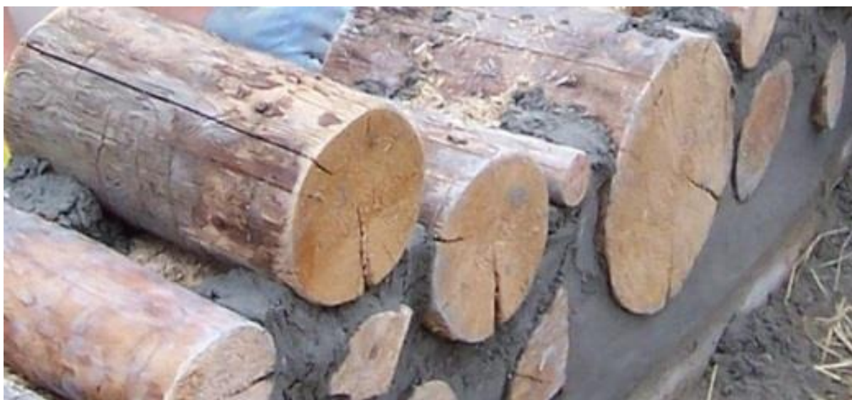
Slika 7: Zid iz drv z vidno notranjo in zunanjo posteljico ter žagovino vmes kot toplotno izolacijo. (Vir slike 7: [32])
