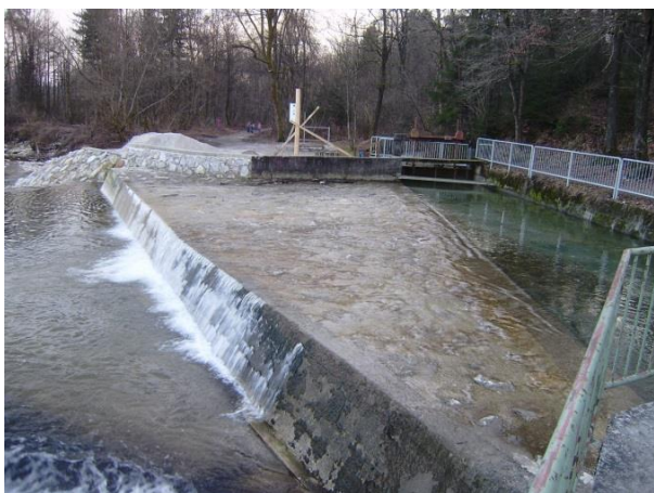
Slika 26: Bočni preliv (Foto: Simon Lesjak)
