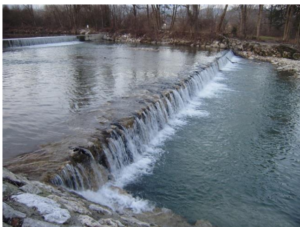
Slika 25: Stabilizacijski oz. talni prag (Foto: Simon Lesjak)
