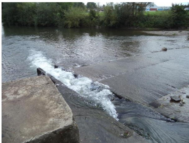
Slika 31: Ribja steza na Bokalškem jezu (Foto: Simon Lesjak)
