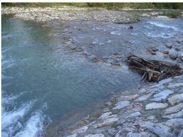
Slika 35: Naplavine dolvodno od stabilizacijskega praga (Foto: Simon Lesjak)
