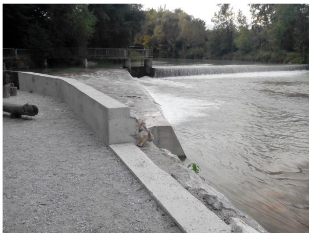
Slika 27: Krilni zid (Foto: Simon Lesjak)
