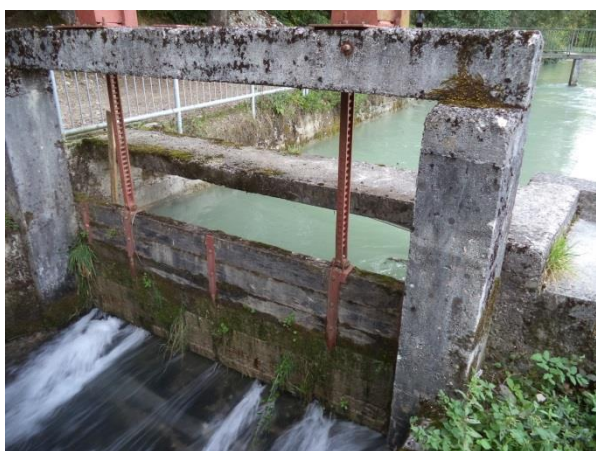
Slika 18: Zapornica, ki regulira pretok po Homški mlinščici (Foto: Simon Lesjak)
