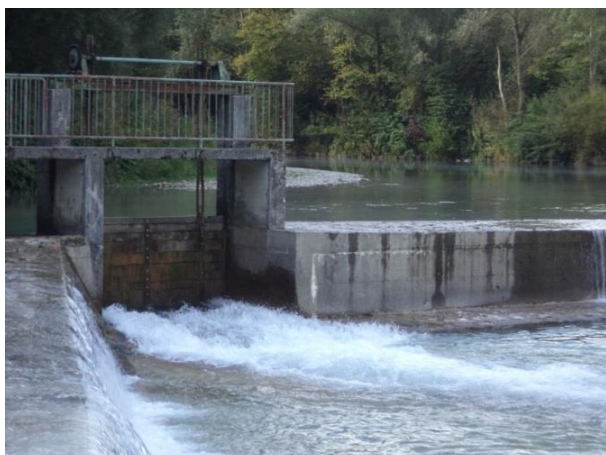
Slika 24: Talni izpust z zapornico (Foto: Simon Lesjak)
