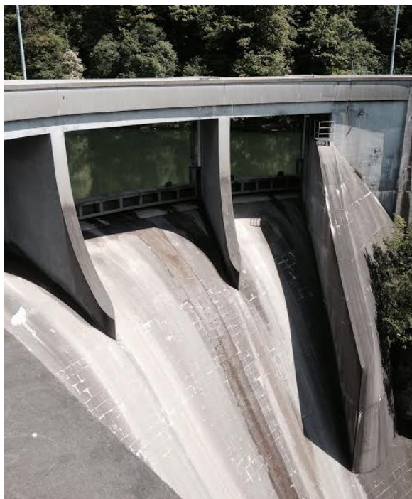
Slika 13: Prelivna polja ter posebne tablaste zapornice
