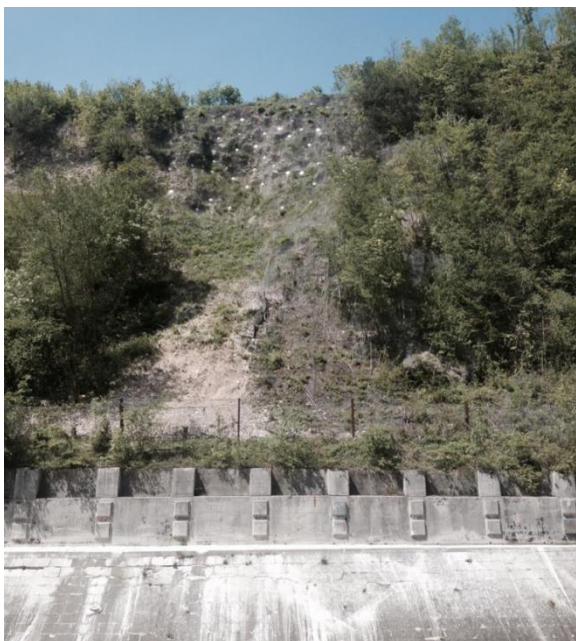
Slika 12: Sanirano območje krušenja pobočja, spodaj pa sidran podporni zid
