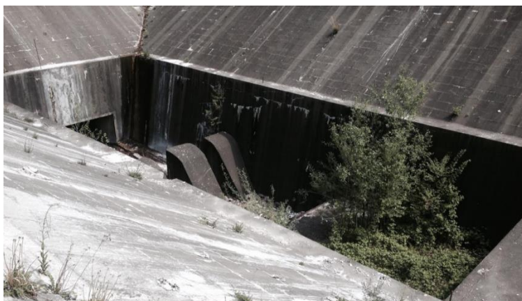
Slika 14: Talni izpust
