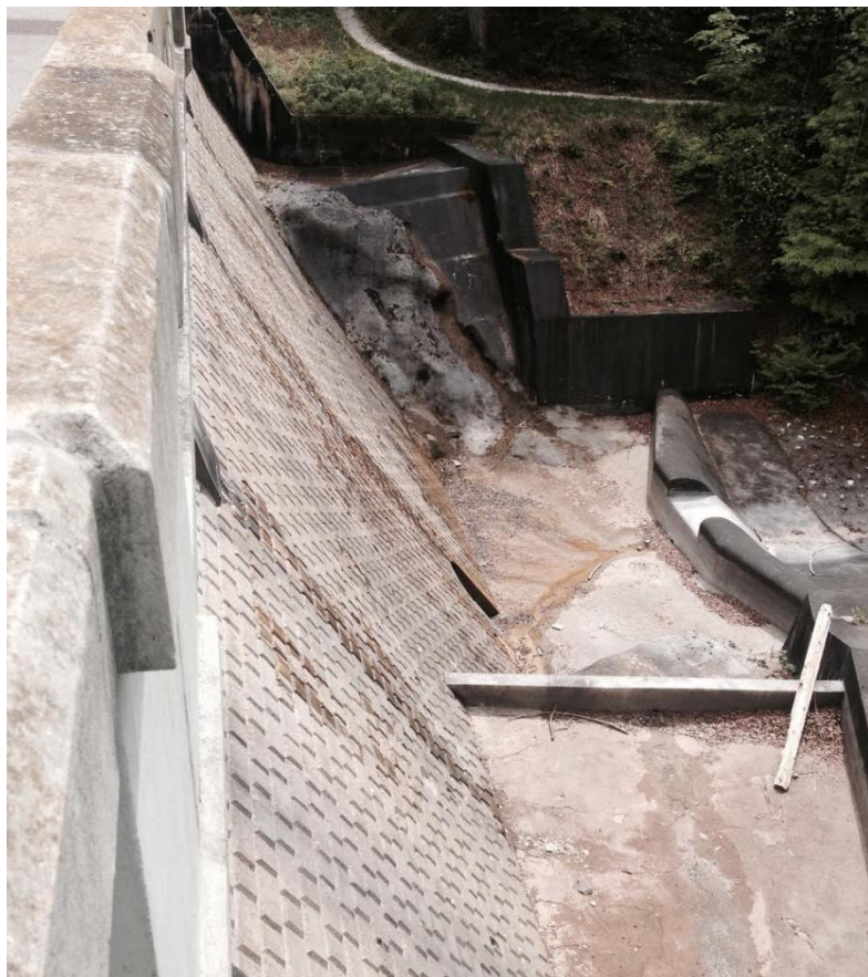
Slika 17: Stanje podslapja pregrade Završnica
