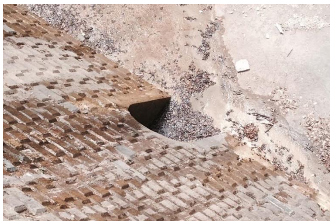
Slika 16: Talni izpust pregrade Završnica
