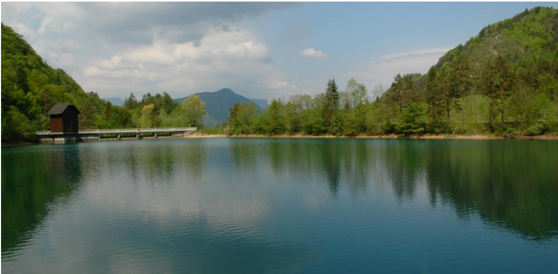
Slika 8: Akumulacija Završnica ter pregradni objekt (SLOCOLD, 2015)
