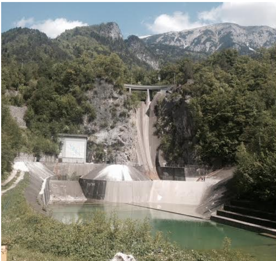
Slika 4: Pregrada hidroelektrarne Moste
