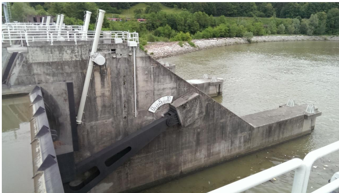
Slika 2: Prelivno polje in nasajena zaklopka z zaježitveno višino 10,5 m. (Vir: osebni arhiv)
