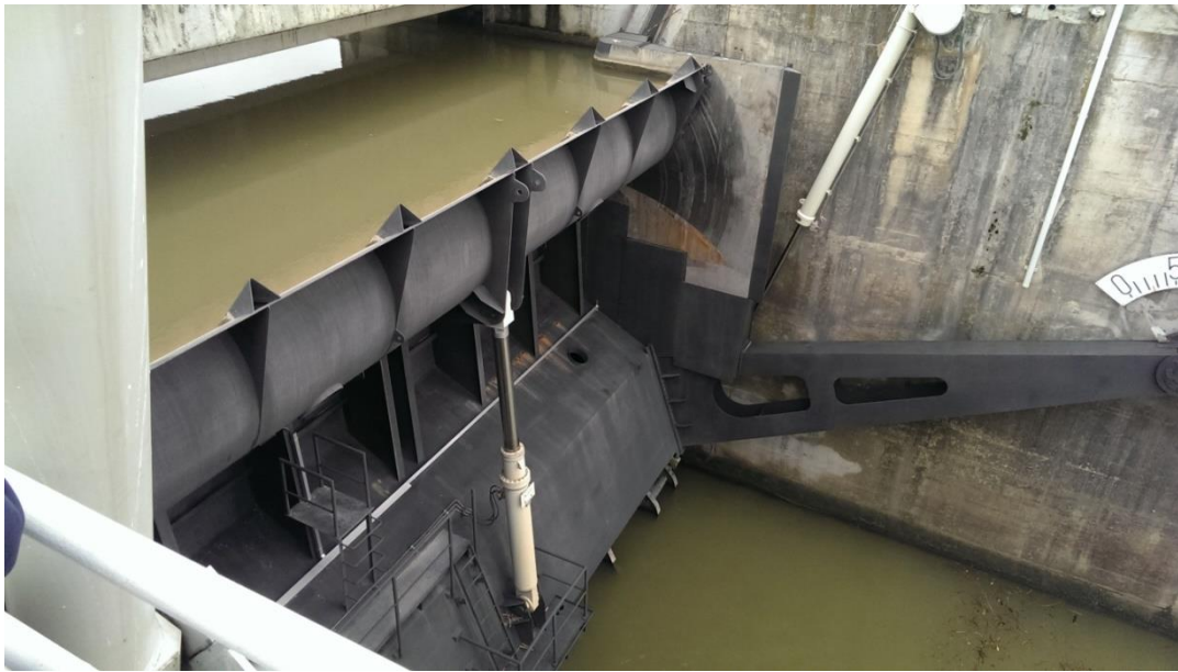
Slika 3: Prelivno polje s segmentno zapornico.
