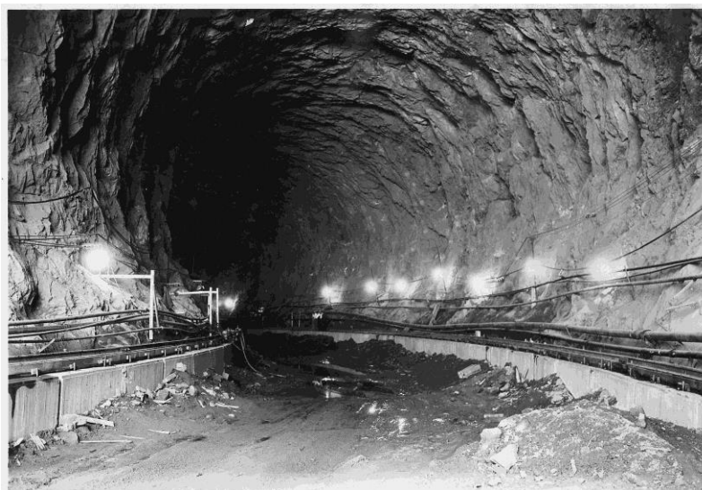
Slika 4: Primer izvrtanega tunelnega prepusta v izgradnji – Hoover Dam (Wikimedia Commons, 1932)
