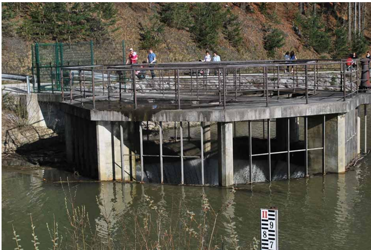
Slika 8: Vtočni objekt, Pregrada Drtijščica (vnaravi.si, 2015)
