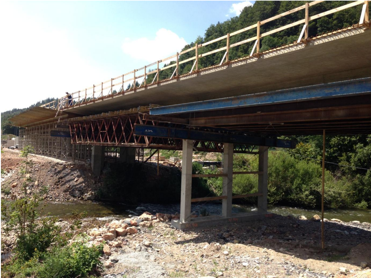
Slika 1: Podporne konstrukcije na mostu čez Soro v Zmincu.
