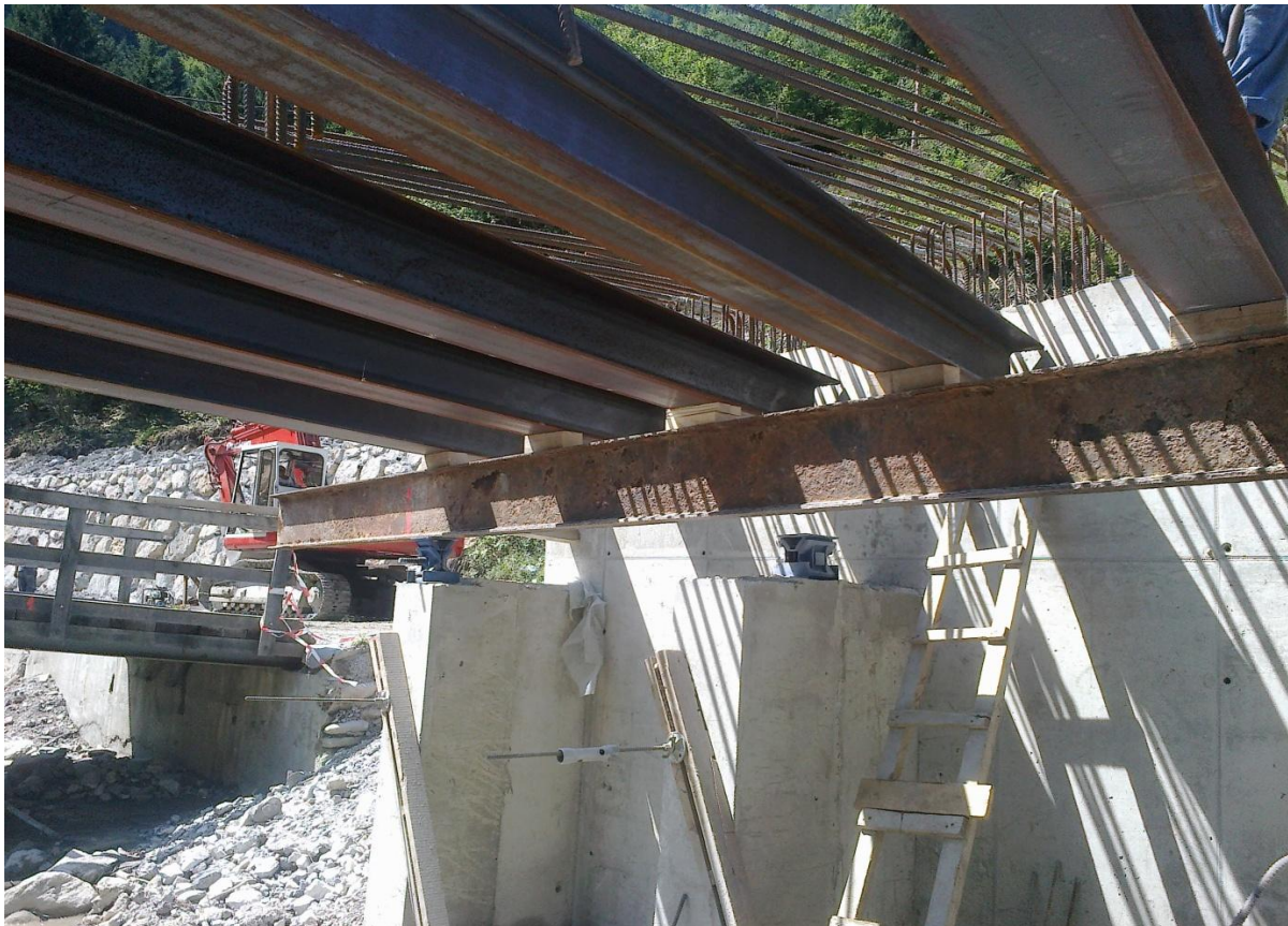
Slika 7: Podporna konstrukcija iz HEB 400-nosilcev
