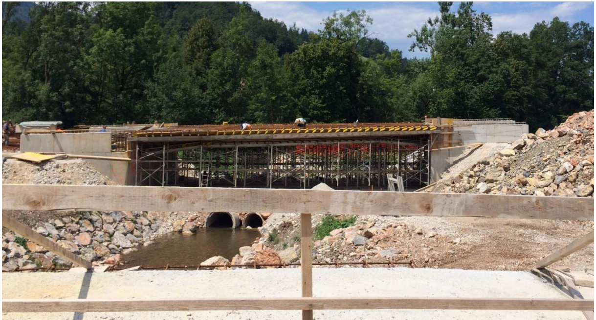
Slika 10: Podpiranje s pomočjo propustov
