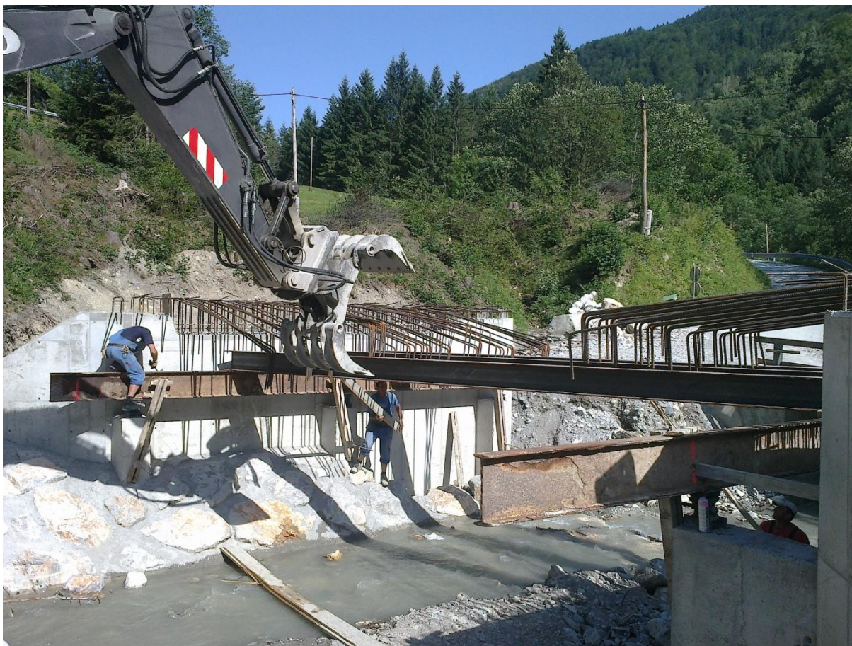
Slika 12: Postavitev podporne konstrukcije iz HEB 400 nosilcev s pomočjo bagra
