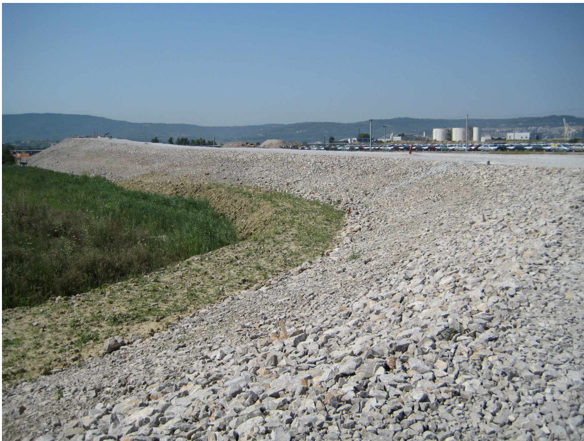
SLIKA 2: Nasip na Ankaranski vpadnici po končanem nasipavanju v mesecu juliju 2007
