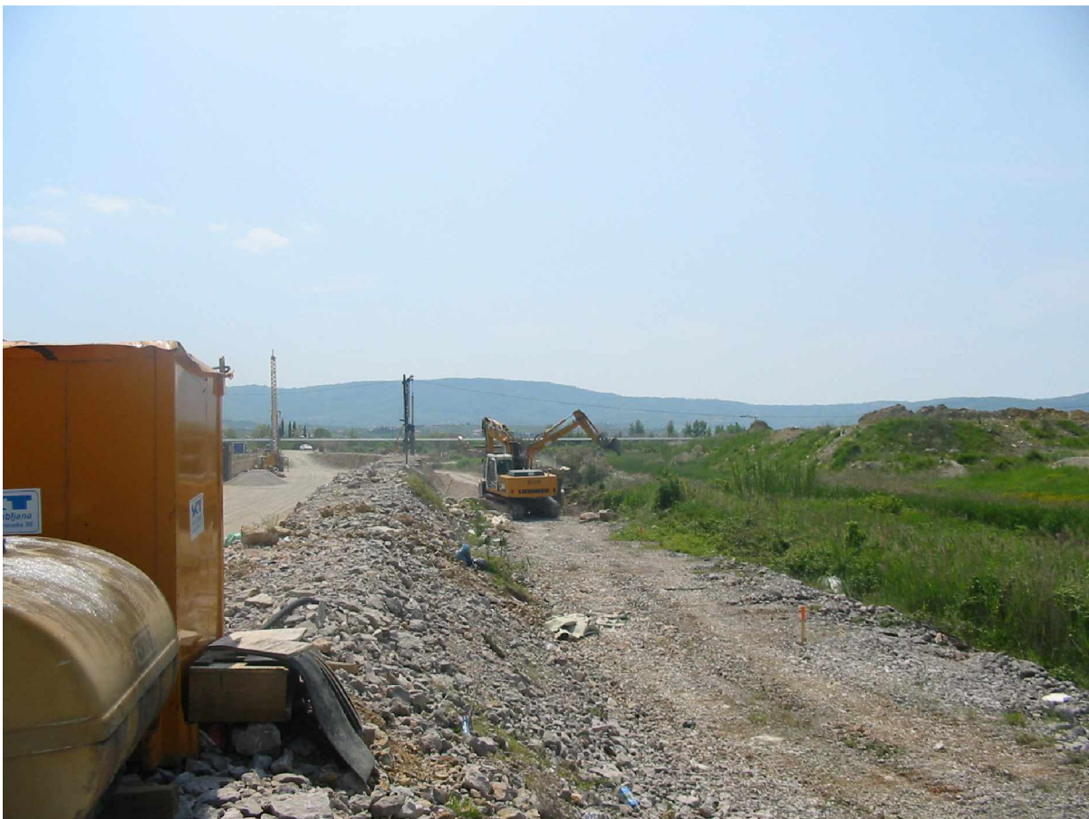
SLIKA 3: Čiščenje terena, odstranitev obstoječega kamnitega nasipa in odriv zemljine v debelini pribl. 30 cm
