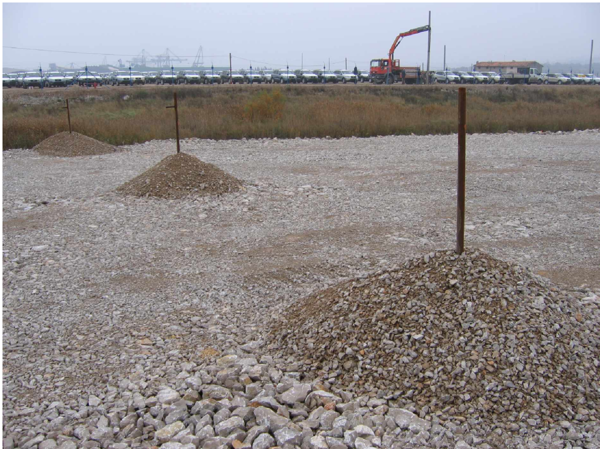
SLIKA 9: Območje posedalnih plošč A13, A14 in A15 med gradnjo
