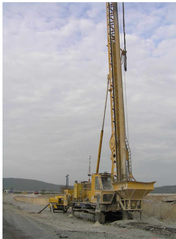
SLIKA 6 : Izvedba gruščnatih kolov po metodi vibracijskega razrivanja
