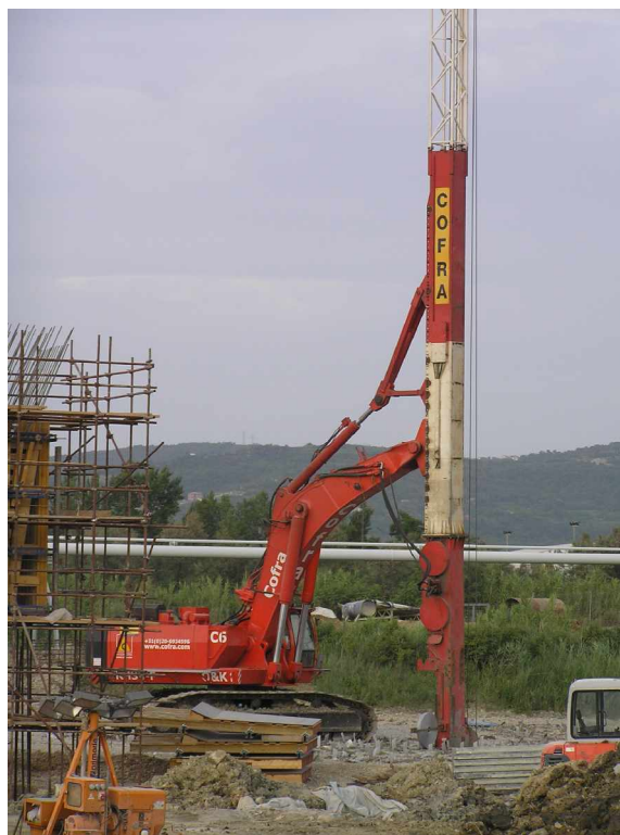
SLIKA 5 : Vtiskanje vertikalnih drenaž
