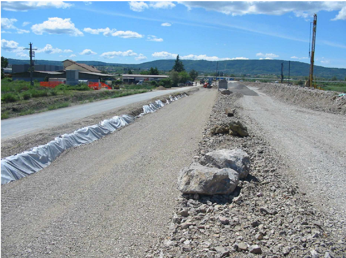
SLIKA 4: Povožni plato nad geotekstilom ob fekalnem kolektorju
