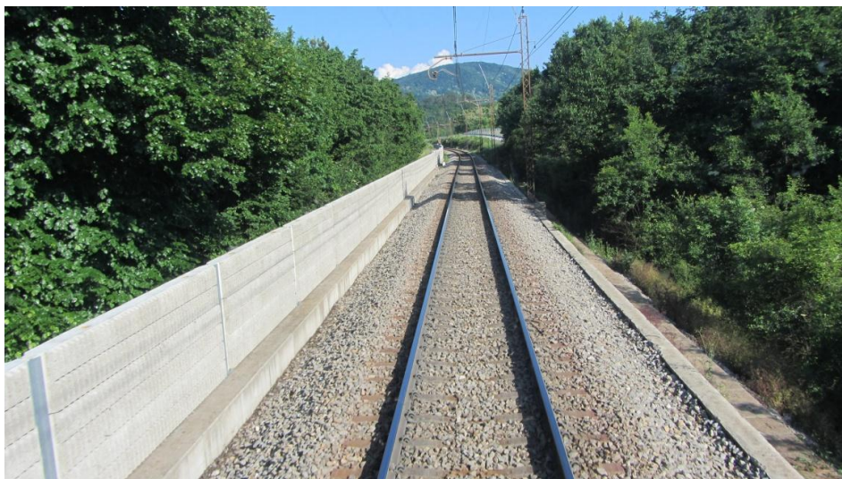
Slika 21: Nov protipožarni zid (vir: lasten vir)
