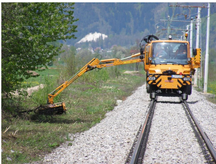
Slika 17: Košnja trave ob progi z vozilom Unimog (vir: lasten vir)
