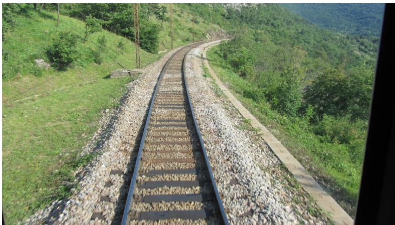
Slika 13: Pomanjkljiva širina požarnovarnostnega pasu (vir: lasten vir)
