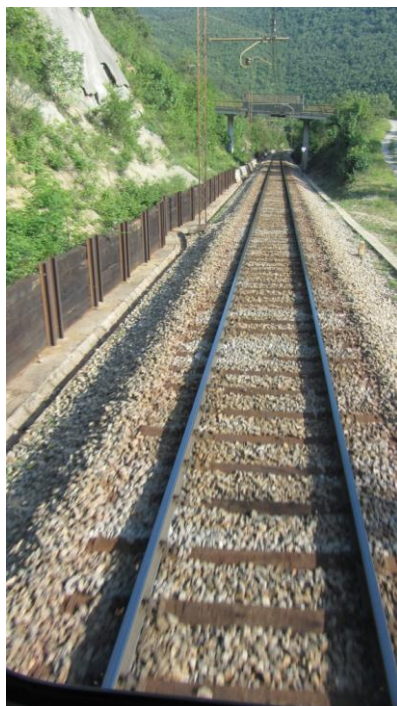
Slika 22: Zastarela požarnovarnostna ograja (vir: lasten vir)
