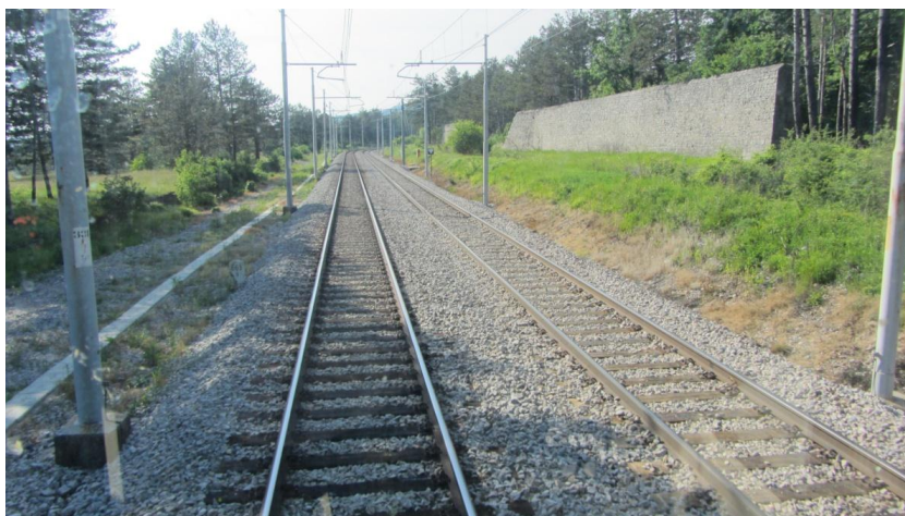
Slika 16: Nepopolna urejenost požarnovarnostnega pasu zaradi neočiščene vegetacije v pasu do požarnega zidu (vir: lasten vir)
