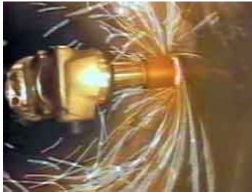
Slika 19: Sanacija z robotom–prikluček 1 Slika 20: Sanacija z robotom–prikluček 2 ( http://www.gradnje-polak.com/kanalizacija/robot.htm ; 9.1.2007)
