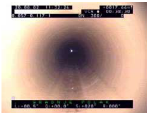
Slika 41: Stanje notranjosti cevi po sanaciji – po vstavitvi impregniranega vložka (Polak, G.2006, Gradnje Polak – kratka predstavitev dejavnosti, Šentjur, Gradnje Polak Gabrijel Polak s.p.)
