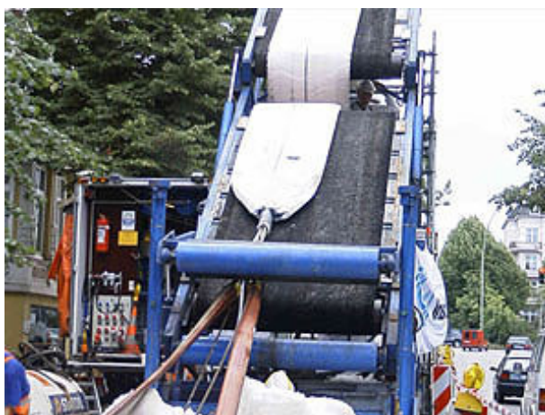
Slika 35: Pritrditev in pričetek vnosa impregniranega vložka ( http://www.S3soncini.it ; 24.2.2007)
