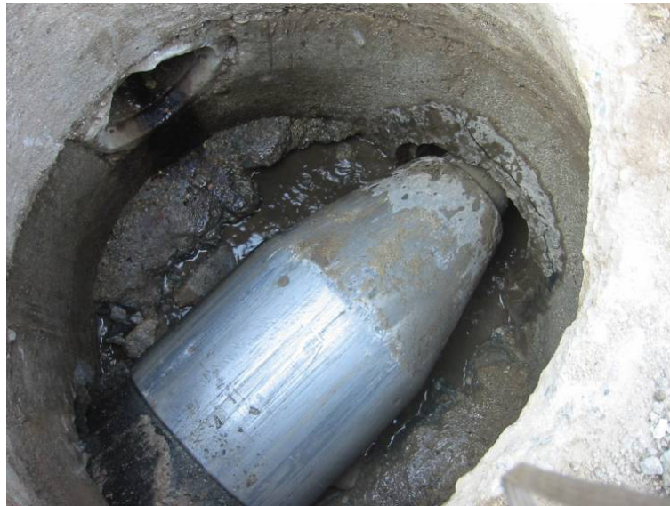
Slika 56: Prehod razbijalne glave skozi obstoječi jašek brez deformacije jaška ( http://www.vilkograd.com ; 9.1.2007)
