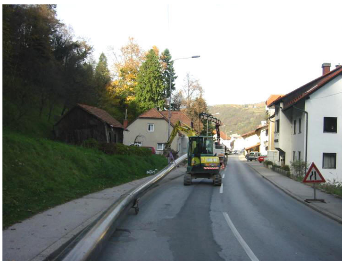
Slika 58: Uvlačenje nove cevi ( http://www.vilkograd.com ; 9.1.2007)
