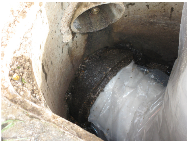
Slika 66: Impregnirani vložek v vstopnem jašku
