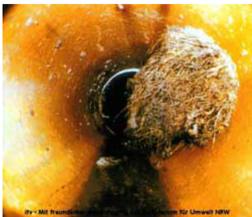
Slika 13: Razraščanje korenin – primer 1 Slika 14: Razraščanje korenin – primer 2 ( http://www.gradnje-polak.com/pregled.htm ; 9.1.2007)
