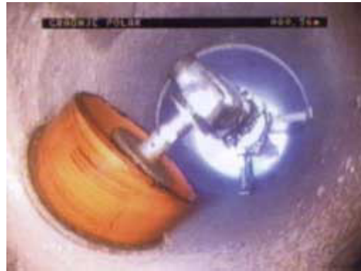
Slika 19: Sanacija z robotom–prikluček 1 Slika 20: Sanacija z robotom–prikluček 2 ( http://www.gradnje-polak.com/kanalizacija/robot.htm ; 9.1.2007)
