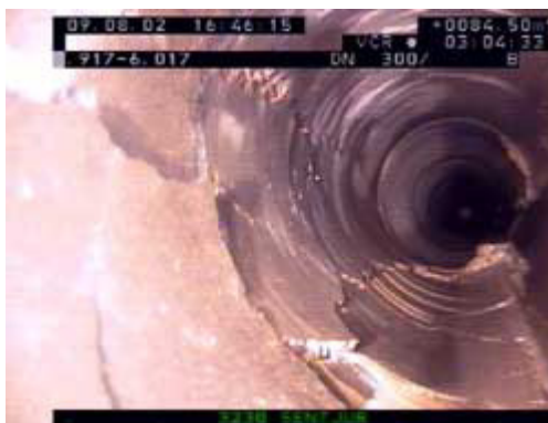
Slika 40: Stanje notranjosti cevi pred sanacijo – pred vstavitvijo impregniranega vložka (Polak, G.2006,Gradnje Polak – kratka predstavitev dejavnosti, Šentjur, Gradnje Polak ,Gabrijel Polak s.p.)
