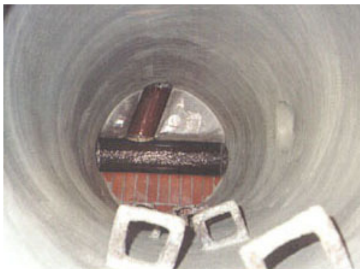
Slika 60: Stanje notranjosti kanalizacijska jaška po sanaciji ( http://www.trolining.de ; 24.1.2007)
