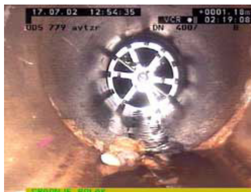
Slika 9: Rezkalna glava ( http://www.gradnje-polak.com/ciscenje.htm ; 9.1.2007)
