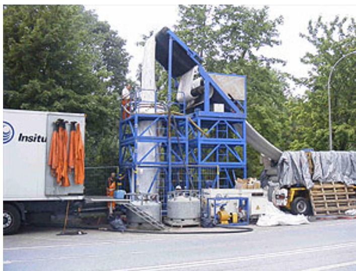
Slika 29: Vodni stolp na vstopnem jašku ( http://www.S3soncini.it ; 24.2.2007)
