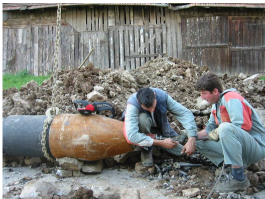
Slika 54: Priprava udarno razširjevalne glave ( http://www.vilkograd.com ; 9.1.2007)
