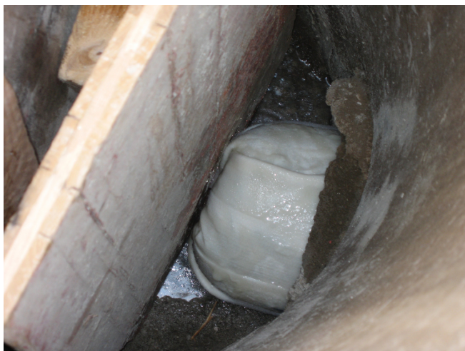
Slika 68: Vstop impregniranega vložka v izstopnem jašku na parceli
