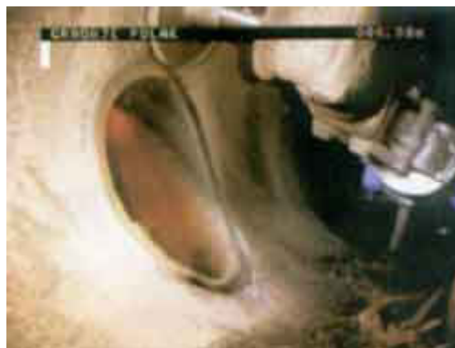
Slika 21: Po sanaciji z robotom – obdelava priključka ( http://www.gradnje-polak.com/kanalizacija/robot.htm ; 9.1.2007)
