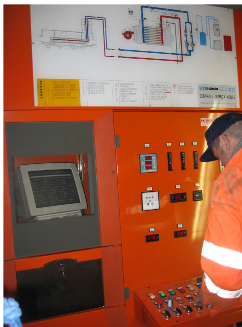
Slika 70: Notranjost komandne kabine, v kateri nadzorujejo postopek polimerizacije
