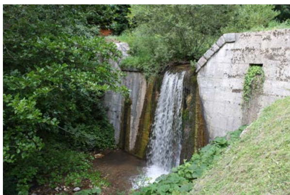
Slika 5: Hudourniška pregrada v strugi hudournika Mačkov graben
