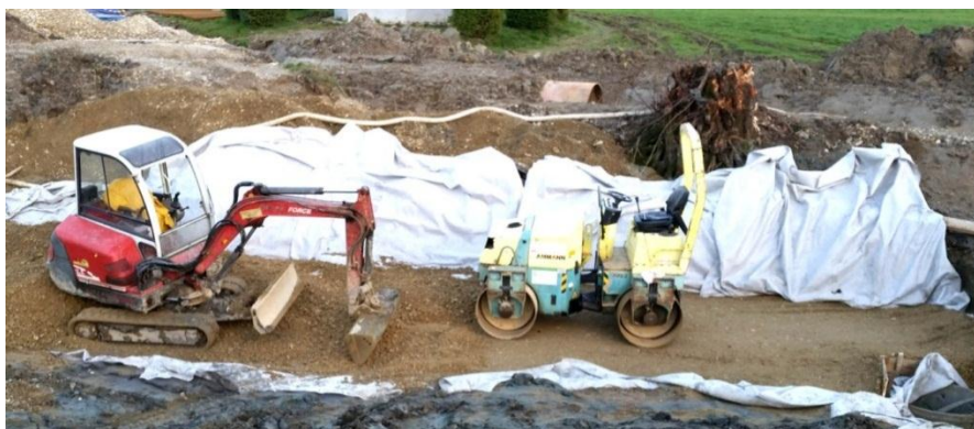
Slika 41: Izvedba temelja iz gramoznega nasutja v Žerovincih Figure 41: Construction of the reinforced soil foundation in Žerovinci
