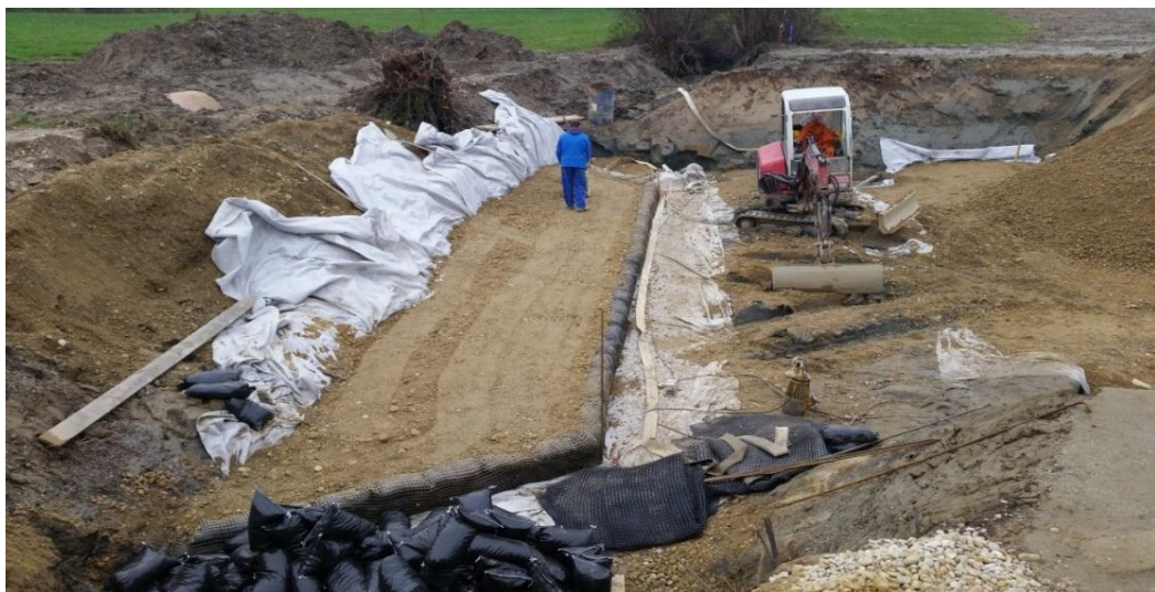
Slika 43: Zgoščevanje izvedenega prvega sloja opornika iz armirane zemljine Figure 43: Compacting first layer of the GRS abutment
