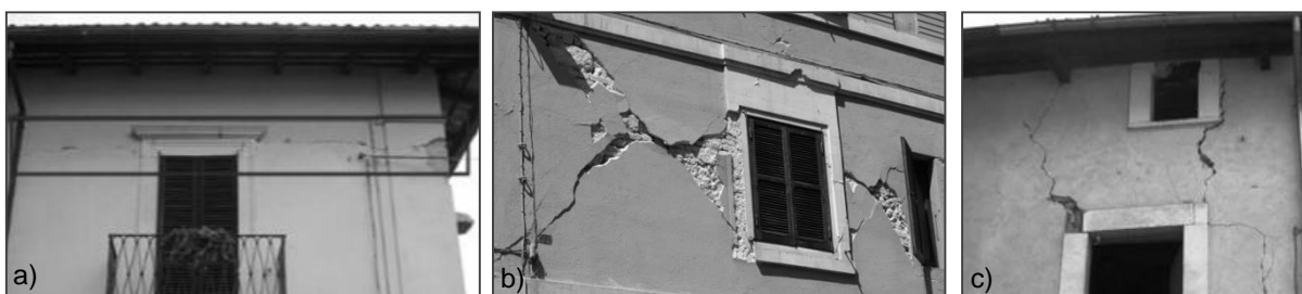
Slika 5: Porušni mehanizmi: a) zdrs b) diagonalne razpoke c) upogibna porušitev (Augenti, Parisi, 2010).
