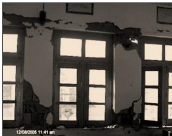
Slika 10: Primer porušitve zidu zaradi upogiba v ravnini zidu (Javed, Bashir, 2012).
