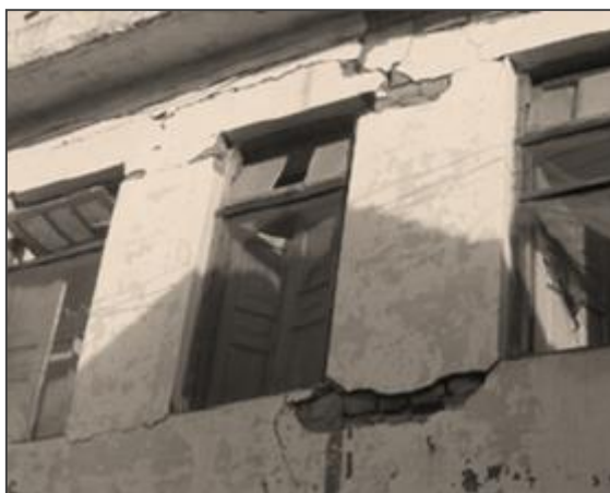
Slika 10: Primer porušitve zidu zaradi upogiba v ravnini zidu (Javed, Bashir, 2012).
