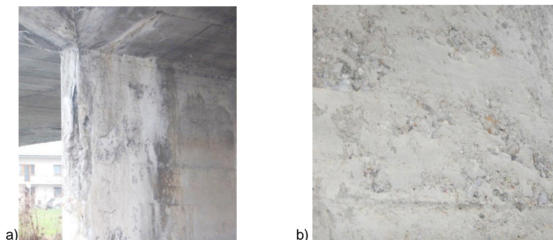
Slika 5: Poškodbe vmesnih stenastih podpor a) Odstopanje in odpadanje betona [IRMA, 2014]; b) Površina delno segregiranega in slabo skomprimiranega betona [IRMA, 2014]
