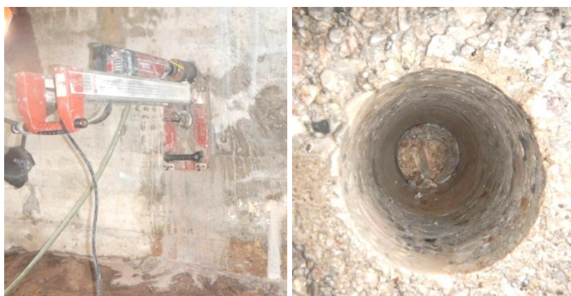
Slika 11: a) Vrtalna naprava za odvzem vzorcev [IRMA, 2014]; b) Vrtina iz katere je bil odvzet betonski vzorec [IRMA, 2014]
