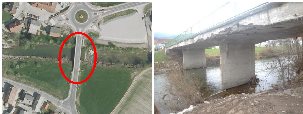
Slika 1: a) Lokacija obravnavanega mostu [Geopedia, 2015]; b) Pogled na obravnavan most iz vzhodne smeri [IRMA, 2014]
