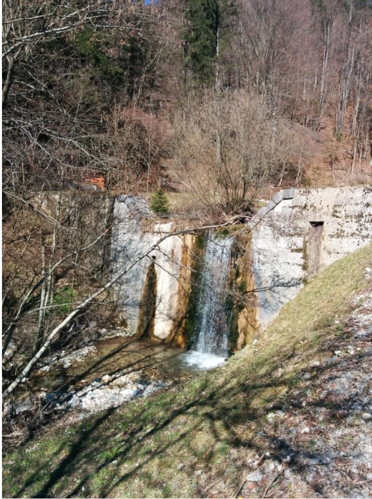
Slika 14: Hudourniška pregrada v hudourniškem območju Mačkovega grabna (foto: Heco, 2015)
