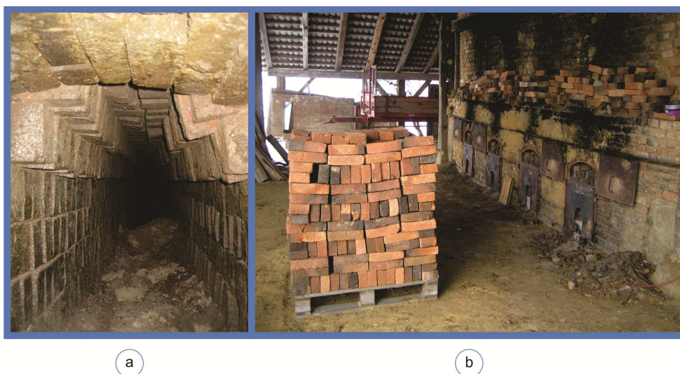
Slika 18: Pogled v kurišče in pečena opeka
