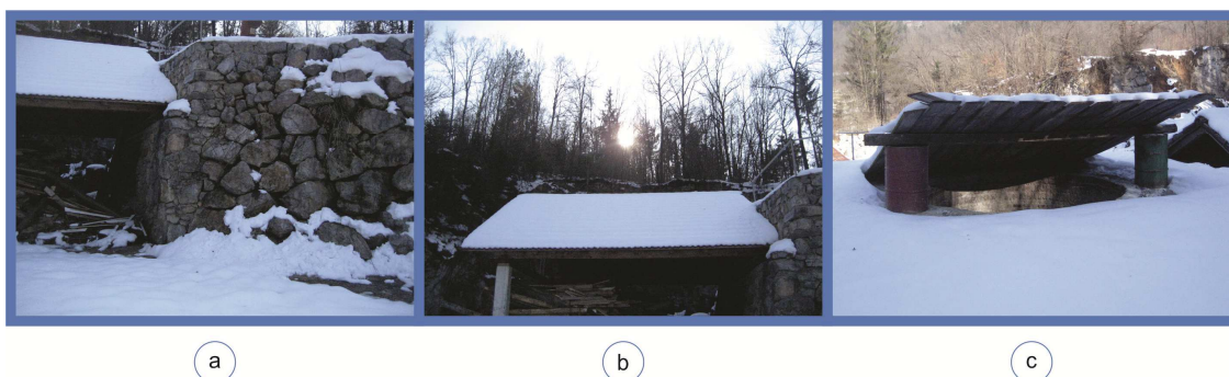
Slika 20: Zunanost zidane peči
