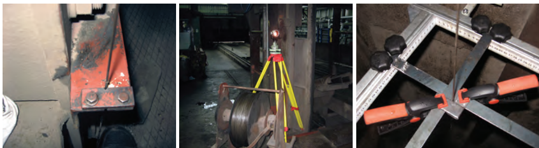
Slika 7: Vpenjanje marke grezila na površini (levo) in v jami (desno) ter signaliziranje marke grezila s preciznim reflektorjem na površini (sredina).
