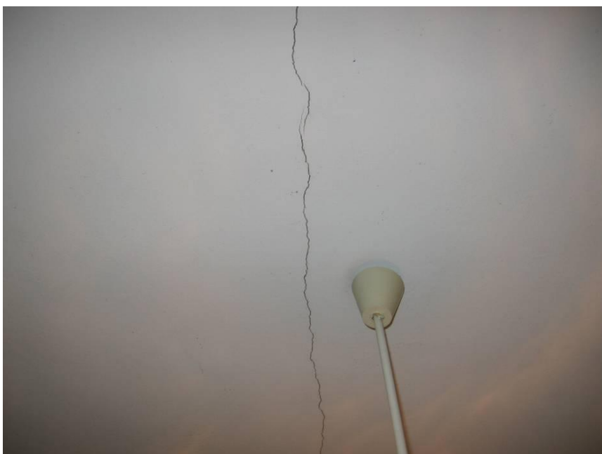
Slika 4: Razpoka na stropni plošči (Štampfl, 2012)
