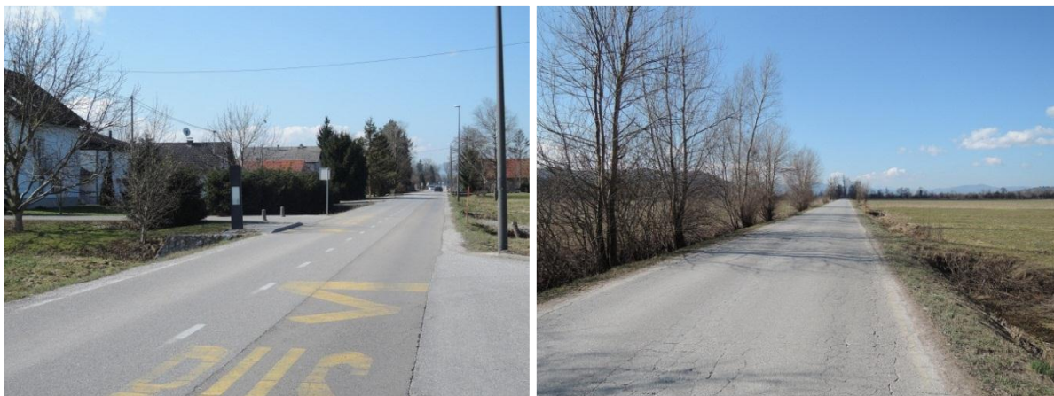
Sliki 11-12: Cesta, ki poteka med Črno vasjo in Podpečjo.
