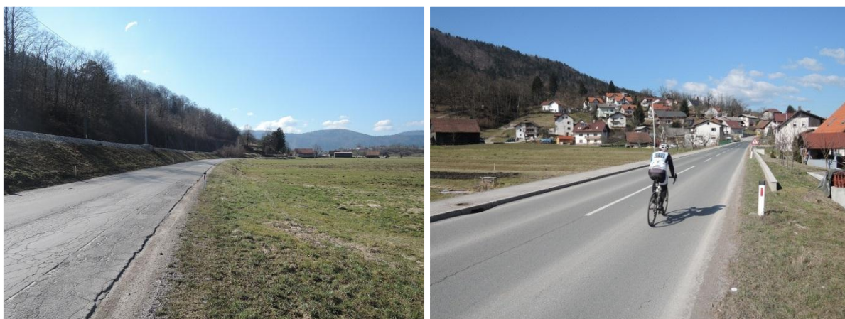
Sliki 13-14: Odsek ceste Podpeč – Brezovica.
