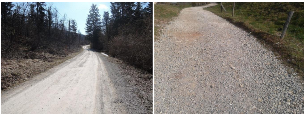
Sliki 7-8: Primer vzdrževane makadamske ceste (levo) in nevzdrževane makadamske ceste (desno)
