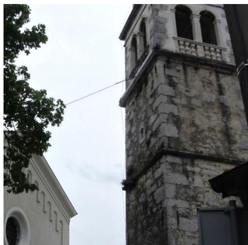
Slika 8: Jeklenica vpeta na zvonik
