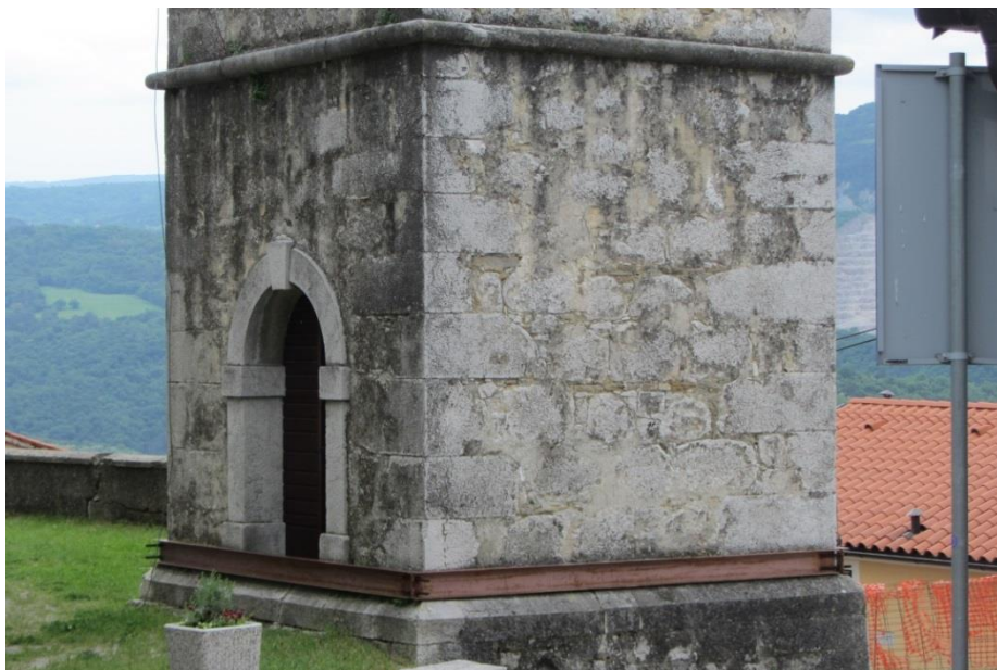
Slika 18: Traverze nad temeljem zvonika
