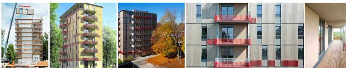
Slika 75: Osemnadstropna večstanovanjska in poslovna lesena stavba na Bavarskem, Holz8 (Binderholz, 2015)
