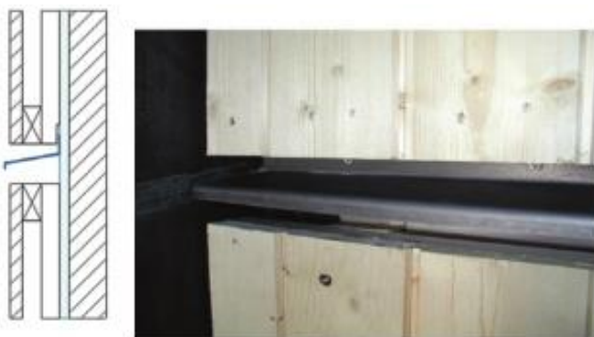
Slika 44: Primer zaščite, ki določen čas preprečuje vertikalni prenos požara po leseni fasadi (SZPV, 2012)
