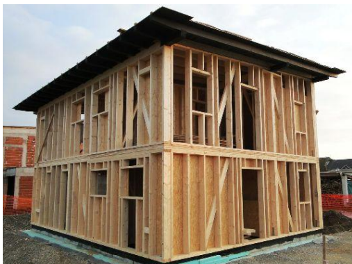
Slika 9: Primer stebrnega objekta (Vir: www.moimoister.net )
