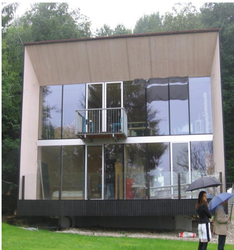
Slika 9: Dvonadstropna enodružinska hiša s stekleno lesenimi stenastimi elementi, zgrajena v mestu Eichgraben, Avstrija (Vir: Žegarac Leskovar, 2013) [6]
