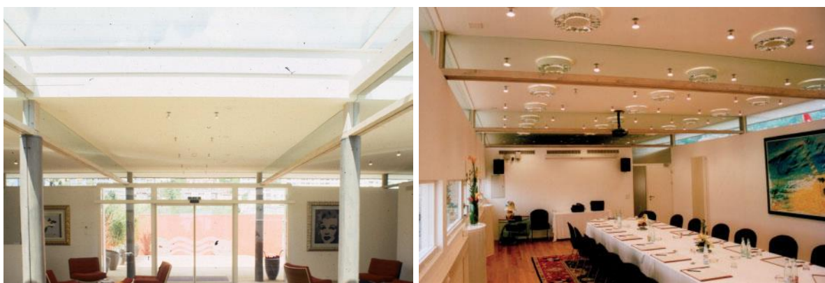
Slika 16: Leseno stekleni I nosilci za strešno obtežbo v hotelu na jezeru Neuenburg, Švica [6]
