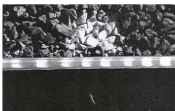
Slika 5.11: Primer obrabe s kratkim valom [64].
