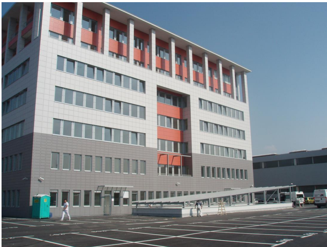
Slika 1: Litostroj objekt C
