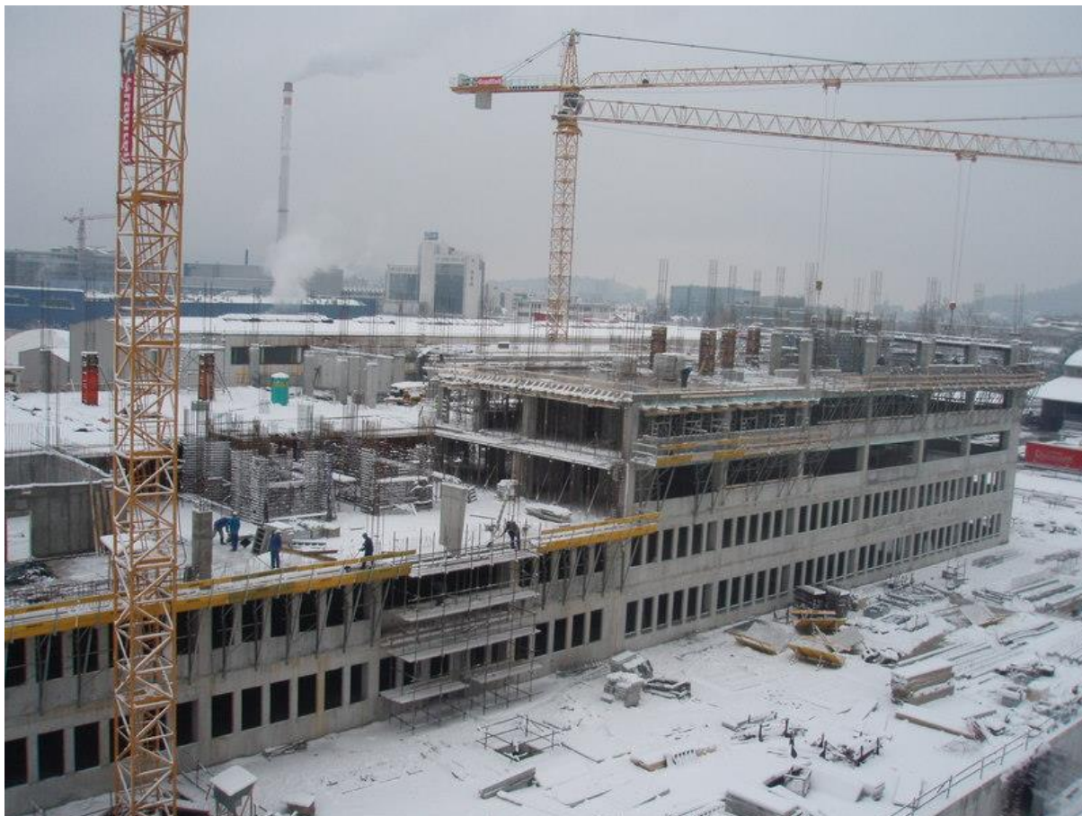
Slika 5: Objekt med gradnjo.
