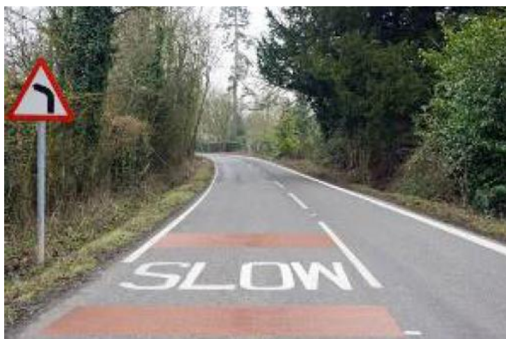
Slika 16: Napis na vozišču – »slow« v kombinaciji s prečnimi označbami (vožnja po levem smernem vozišču) [39]
