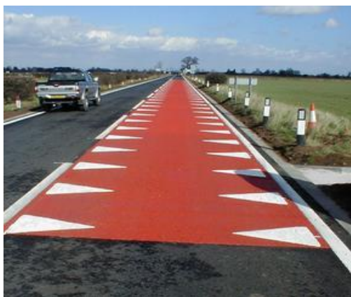
Slika 23: Vhod v naselje z vzorcem zob morskega psa na barvni vozni površini (levo) in vhod v naselje z neobičajno velikimi prometnimi znaki ter ločilnim otokom (desno) [39] [63]
