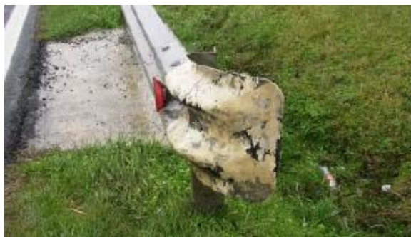
Slika 34: Neustrezno oblikovan zaključek ograje (levo) in neprimerno izveden prehod med zaključkoma ograj pred mostom (desno) [83] [30]
