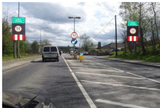
Slika 23: Vhod v naselje z vzorcem zob morskega psa na barvni vozni površini (levo) in vhod v naselje z neobičajno velikimi prometnimi znaki ter ločilnim otokom (desno) [39] [63]
