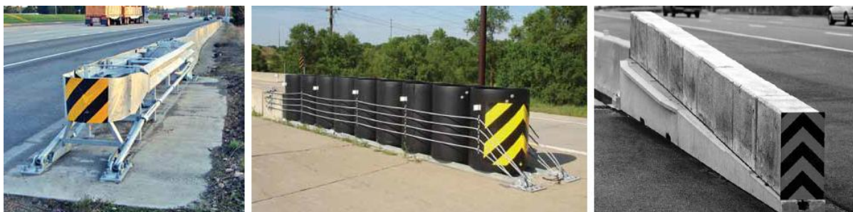
Slika 60: Blažilec trkov z jeklenim sistemom (levo), polietilenskimi cilindri (v sredini) in moduli iz perlitnega betona (desno) [49]
