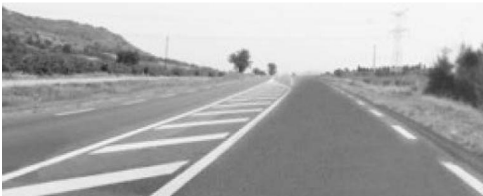
Slika 26: Robni črti in vzorec šrafure, ki so izvedeni v povečani širini pred vstopom v križišče [69]
