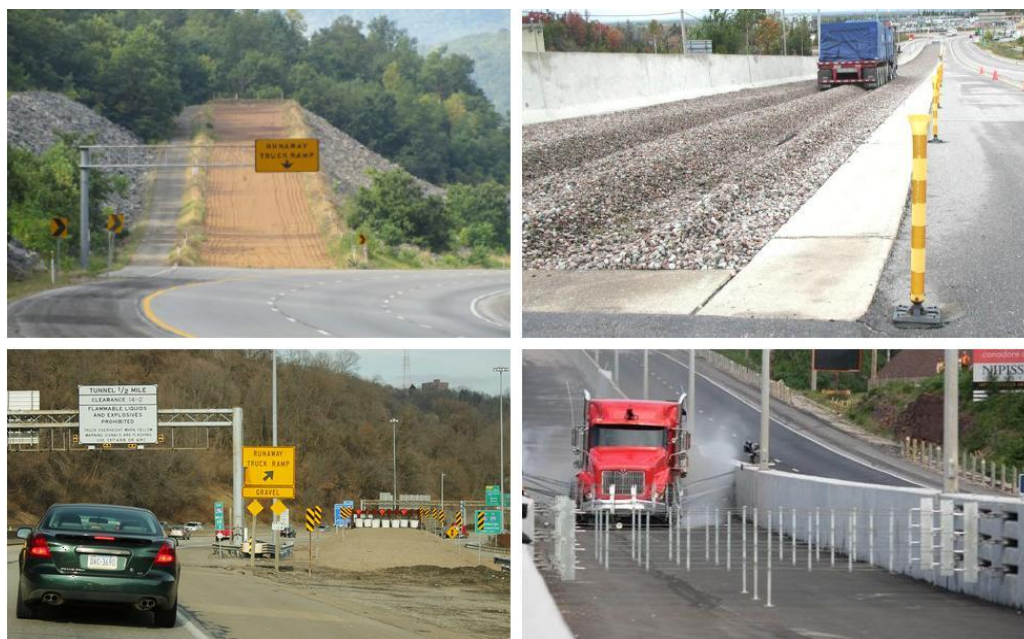
Slika 42: Gravitacijski zasilni izvoz (zgoraj levo), zasilni izvoz z zaustavnim bazenom (zgoraj desno), nasipom (spodaj levo) in povlečnimi mrežami (spodaj desno) [98] [99] [100]
