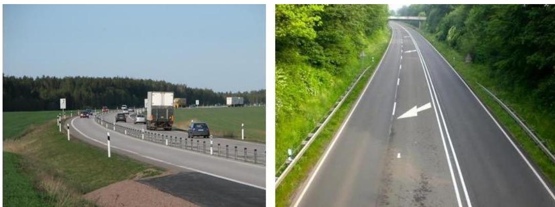
Slika 28: 2+1 cesta, na kateri smerni vozišči ločuje jeklina kabelna varnostna ograja (levo) in dvojna sredinska ločilna črta (desno) [73]
