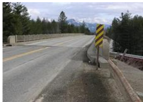
Slika 34: Neustrezno oblikovan zaključek ograje (levo) in neprimerno izveden prehod med zaključkoma ograj pred mostom (desno) [83] [30]
