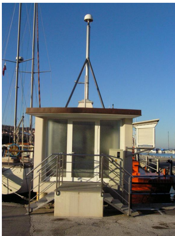
Slika 3: Objekt nove mareografske postaje v Kopru (Foto: B. Koler)
