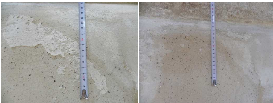
Slika 12: Mesto vzorčenja za vzorec H1. Sol se na površini zidu izloči v obliki skorje, mesto vzorčenja pred odvzemom vzorca (levo). Mesto vzorčenja po odvzemu vzorca (desno) Figure 12: The position of sample H1. The salt looks like crust, position before sampling (left). Position after sampling (right)
