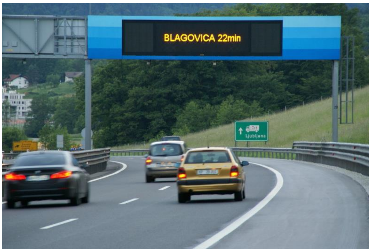
Slika 1-1: Primer obveščanja voznikov o potovalnih časih preko grafičnega prikazovalnika spremenljive prometno-informativne signalizacije
