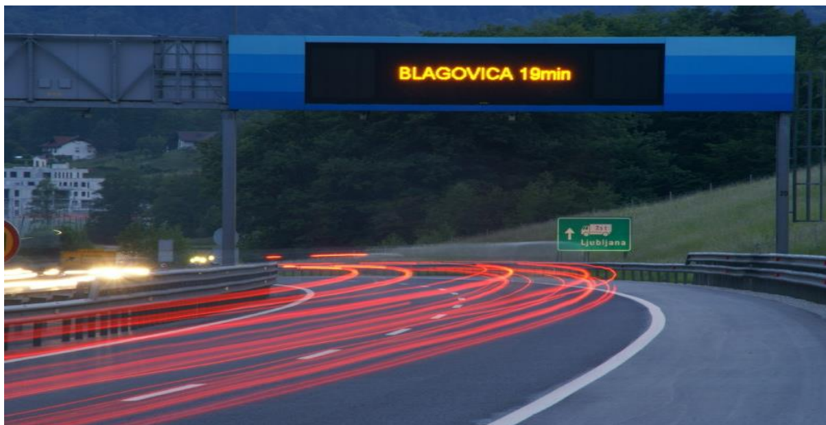
Slika 4-27: Primer obveščanja voznikov o potovalnih časih preko grafičnega prikazovalnika spremenljive prometno-informativne signalizacije, nameščenim pred izvozom Vransko v smeri Ljubljane
