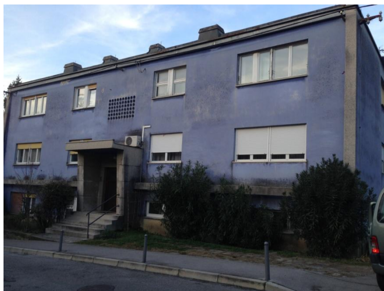
Slika 6: Večstanovanjska stavba v Mestni občini Koper - Smedela, z ravno streho, zgrajena leta 1956 [15]
