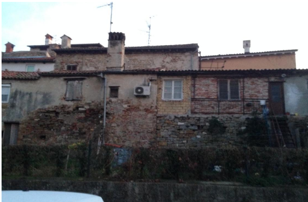
Slika 4: Enostanovanjske stavbe v Mestni občini Koper (staro mestno jedro), zgrajene pred 1900 [15]
