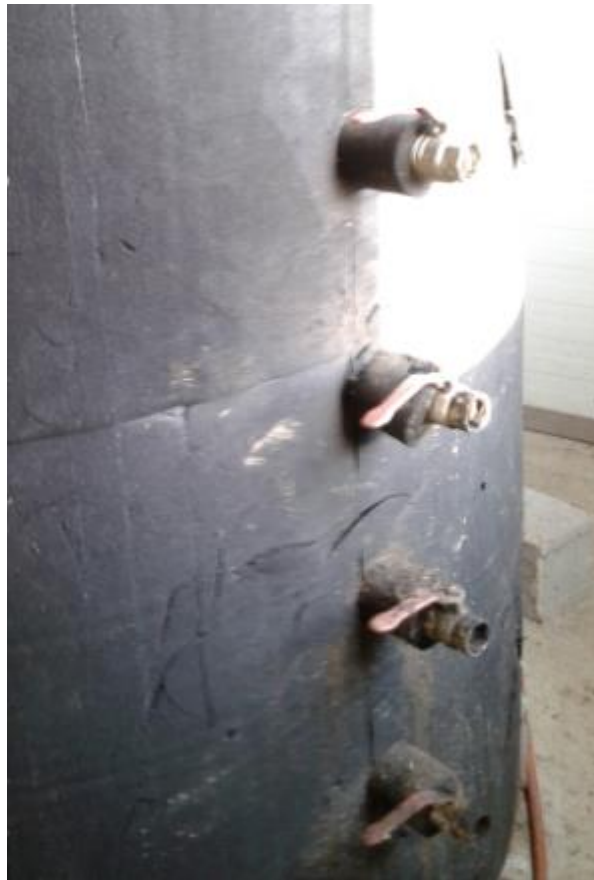
Slika 15: Kroglični ventili za zajem vzorca na različnih globinah
