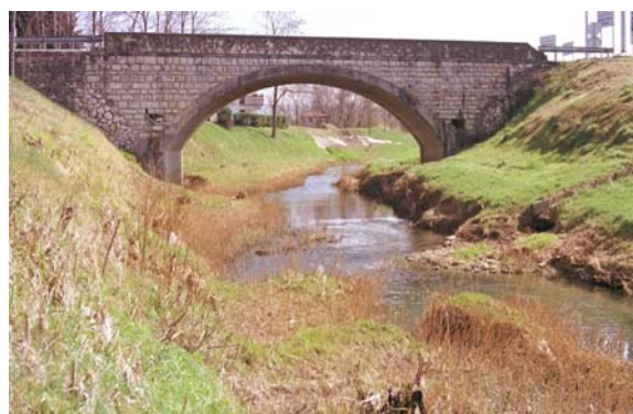
Fotografiji 38 in 39: Prepust brez brežin in brez sedimenta in prepust z brežinami in s sedimentom
