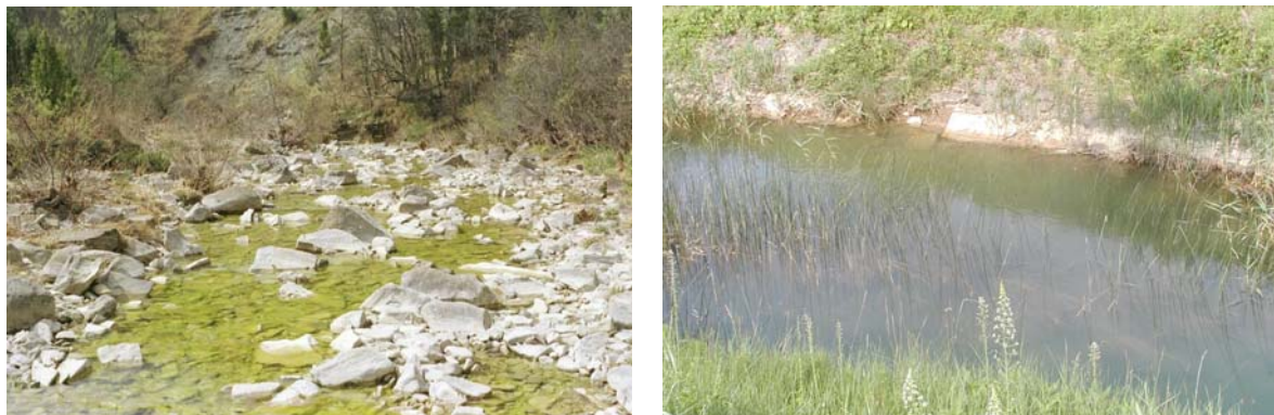
Fotografiji 40 in 41: Grobljasto dno struge in utrditev dna struge s kamnometom v mokro
