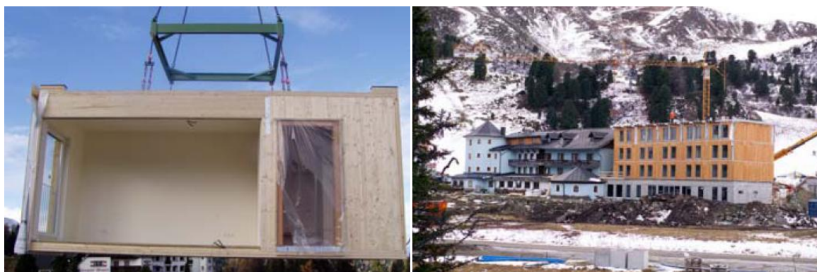
Slika 3.6: Modularne enote iz križno lepljenih plošč – Hotel Kornock (Die.modulfabrik)
