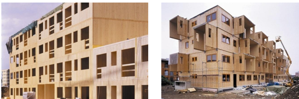
Slika 2.12: Primer večnadstropnega objekta iz križno lepljenih masivnih panelov (KLH)
