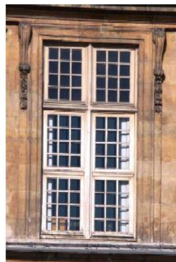
Slika 2: Tipična steklitev v lesenem okvirju v gradbeništvu 17. stoletja [3]
