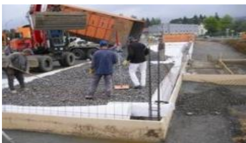
Slika 14: Vgradnja penjenega stekla pred temeljenjem [4]
