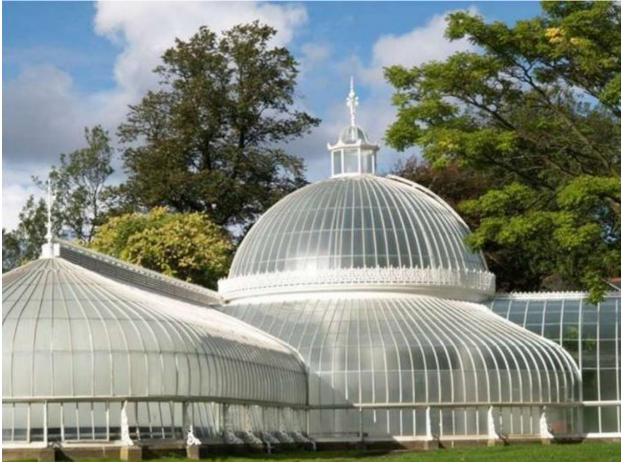
Slika 39: Steklени paneli zagotavljajo stabilnost kupole [9]
