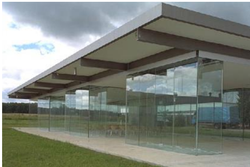
Slika 38: Jeklana streha podprta z steklenimi paneli [9]
