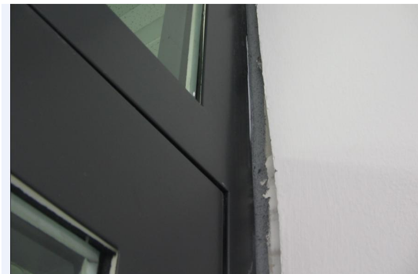
Slika 7: Očitna, s prostim očesom vidna napaka – neobdelan stik stene in okenske okvirja (Energoplan d.d., 2007)
