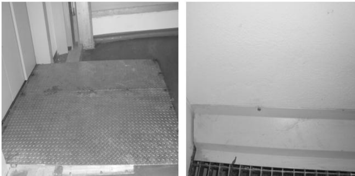
Slika 8: Izveden prag pred dvigalom (Zahtevak št. 10) in izvedba stika rešetke in zidu (Zahtevak št. 11) (Energoplan d.d., 2009)
