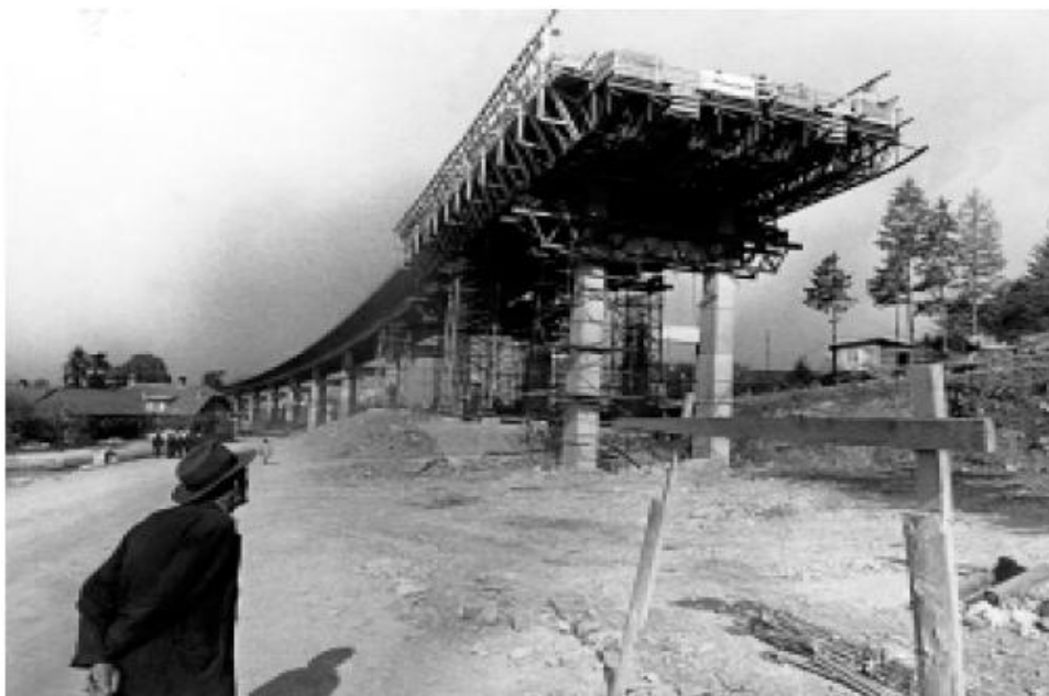
Slika 8: Gradnja viadukta Verd, odsek avtoceste Vrhnika – Postojna ( http://www.dars.si )
