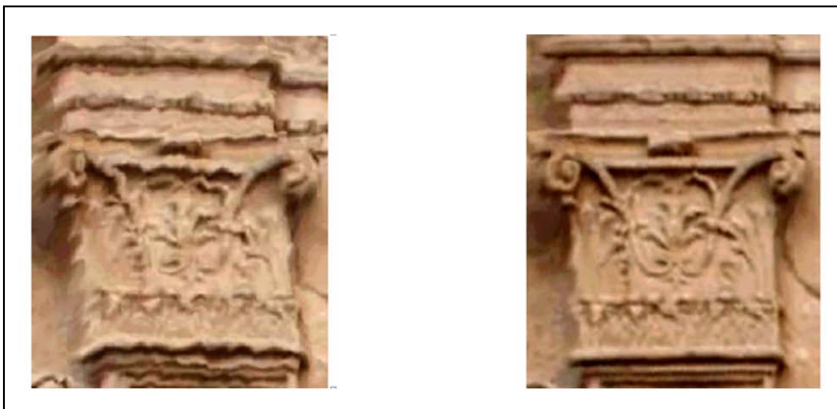
Slika 16: 3D-model brez filtriranja (levo) in filtrirani 3D-model (desno) (Vir: Bornaz in sod., 2004).
