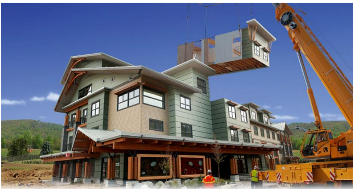
Slika 4 - Primer modularne gradnje
