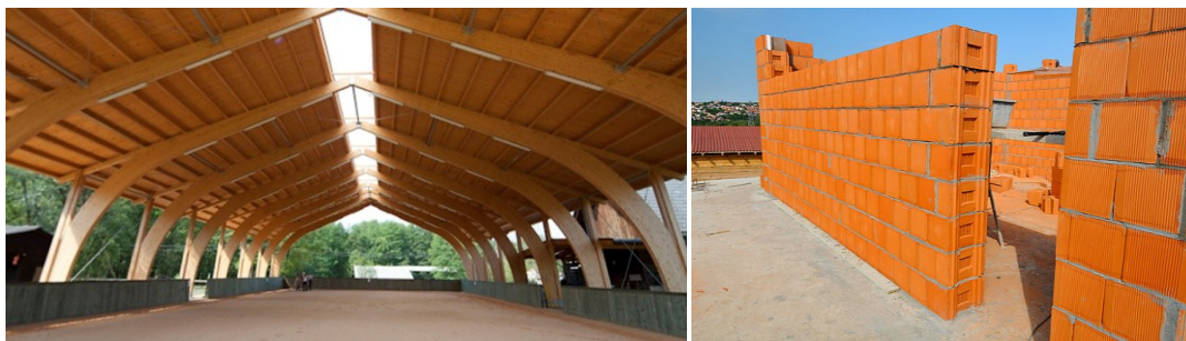
Slika 1: Primer endoskeletne konstrukcije z leseno nosilno konstrukcijo (levo) [6] in eksoskeletna konstrukcija z opečno nosilno konstrukcijo (desno) [7]
